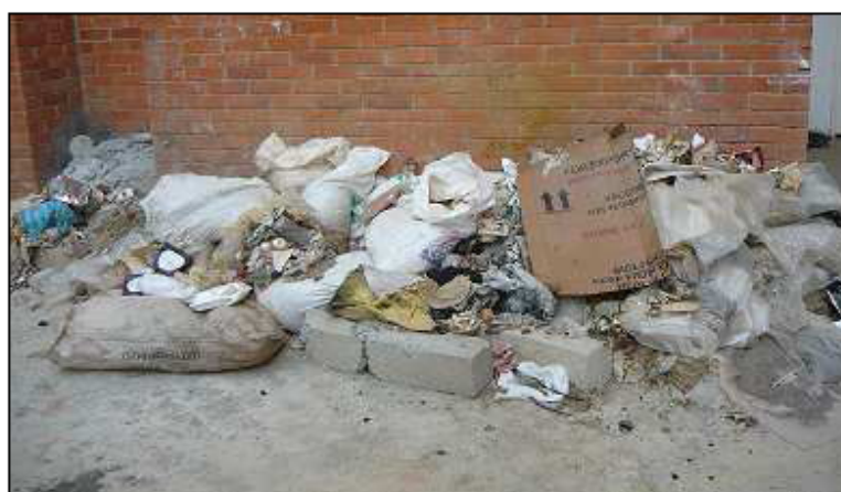
Foto 6. Escombros a las afueras del edificio
