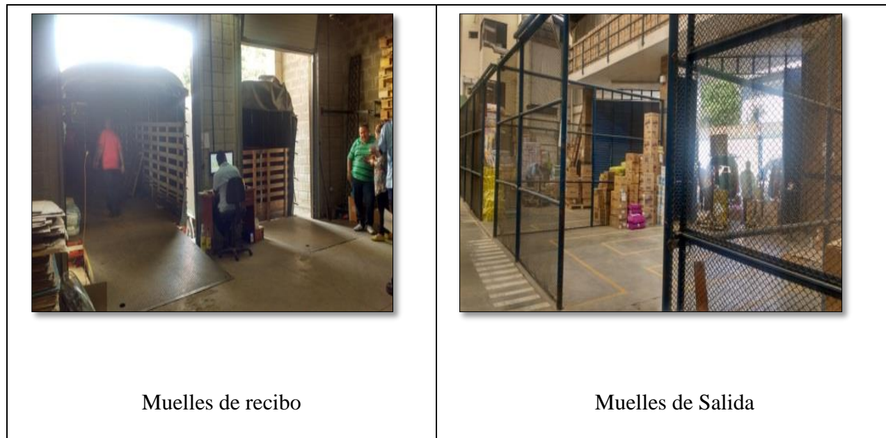
Figura 2 Muelles de Recibo y Despacho Distribuciones Pastor Julio Delgado S.A.
