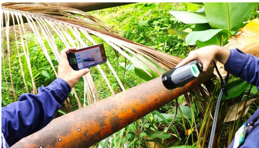
Figura 5. Inspección de la tubería.
