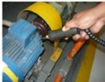
Figura 36. Medición de temperatura del acople
