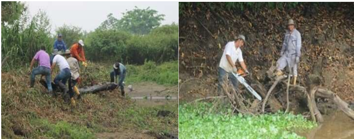
Fotografía 23. Destronque y poda de la vegetación caída en caños.
