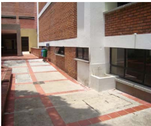
Figura 40. Extensión total costado Oeste de la edificación.
