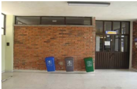
Figura 44. Ingreso a las Instalaciones, costado Sur.
