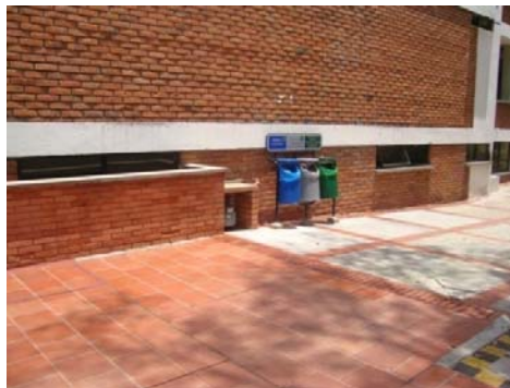
Figura 46. Ventanas costado Oeste de la edificación.
