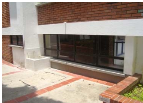
Figura 47. Ventanas costado Oeste de la edificación.
