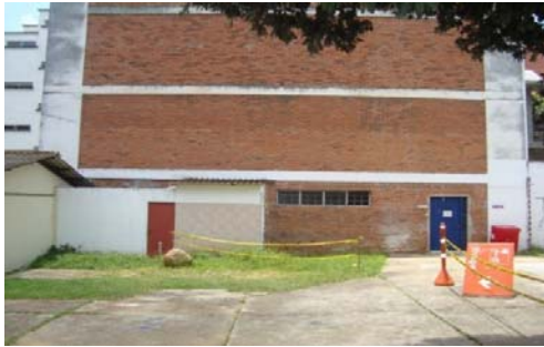
Figura 43. Costado Este de la edificación.
