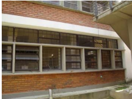
Figura 42. Ventanas costado norte de la edificación.
