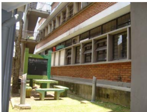
Figura 37. Costado norte de la edificación.
