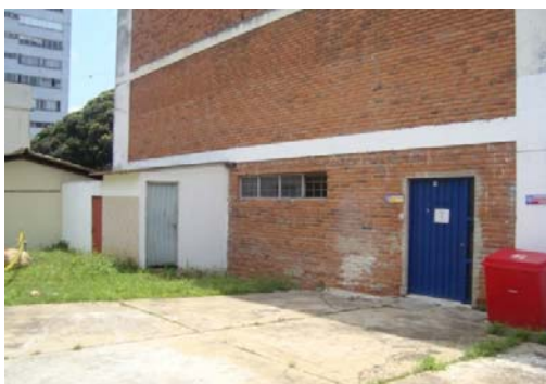
Figura 38. Extensión total costado Este de la edificación.
