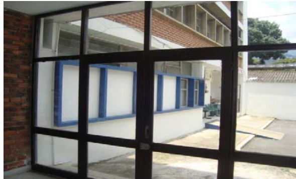
Figura 45. Ventanas costado Sur de la edificación.
