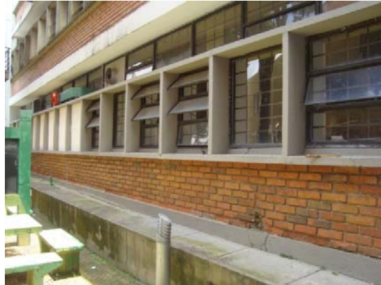
Figura 41. Ventanas costado norte de la edificación.
