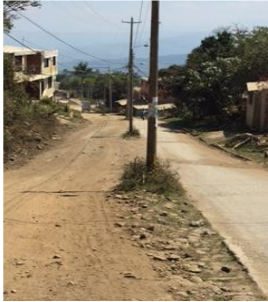
Figura 4. Obra antes de la ejecución. Tomado de: Información de la oficina de la Secretaria de Infraestructura de la Gobernación de Santander.
