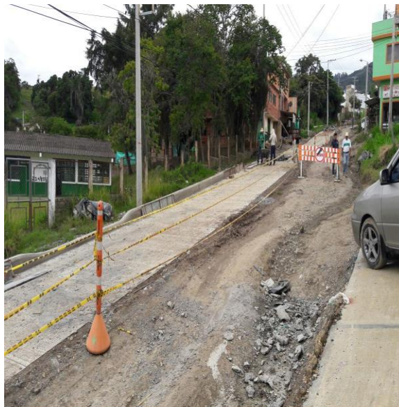
Figura 5. Obra durante la ejecución. Tomado de: Información de la oficina de la Secretaria de Infraestructura de la Gobernación de Santander.
