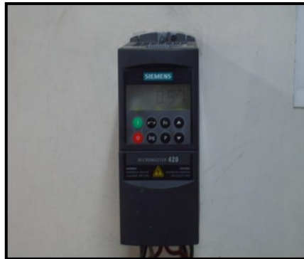
Figura 8: Controlador de velocidad. (SIEMENS)
