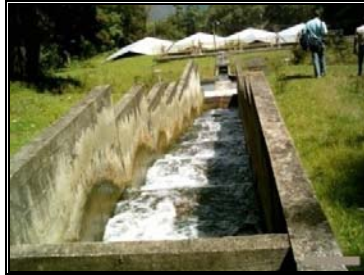
Ilustración N° 3. Mezcla Rápida para Floculación Acueducto.
