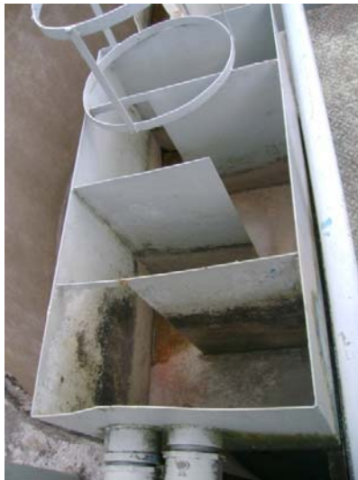
Ilustración N° 49. Caja de Repartición de P.T.A.P.
