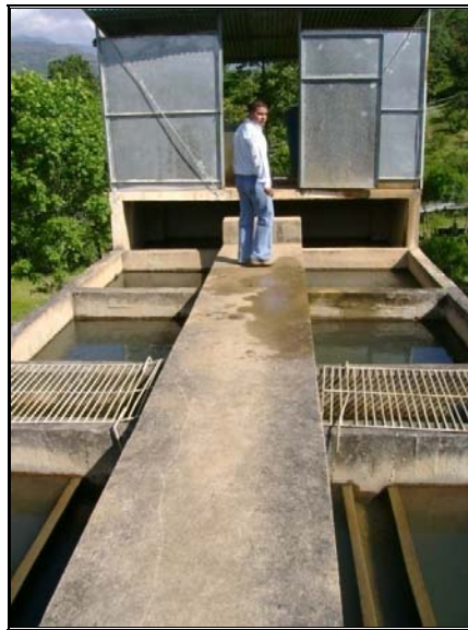
Ilustración N° 39. Desarenador y Floculador.
