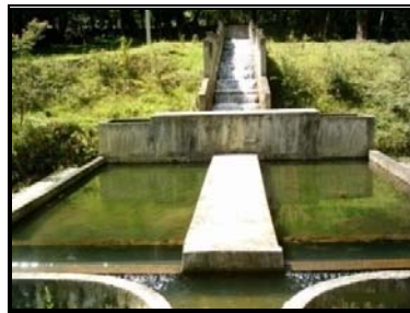
Ilustración N° 4. Floculación.
