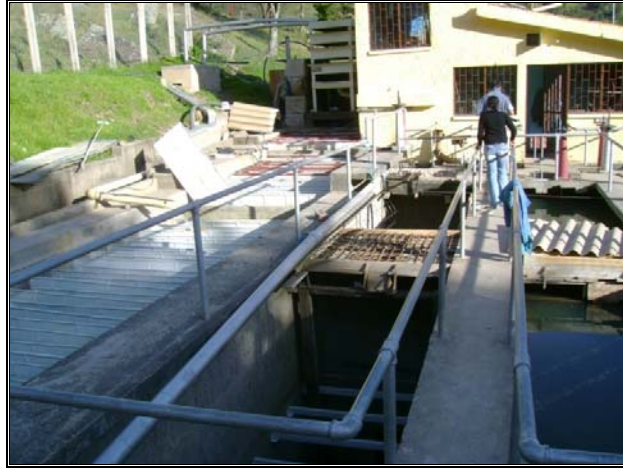
Ilustración N° 18. P.T.A.P. (Floculador y Filtros).
