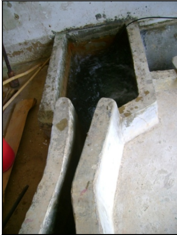
Ilustración N° 49. Caja de Repartición de P.T.A.P.
