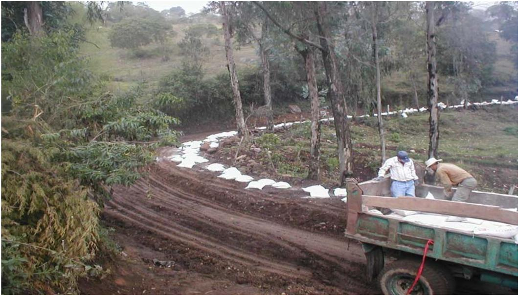
**Foto 6. Ubicación y aplicación del aditivo estabilizador fase 2**
