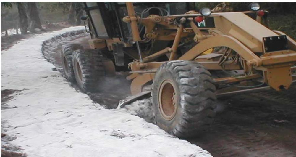
**Foto 9. Mezclado del suelo con el aditivo fase 3**
