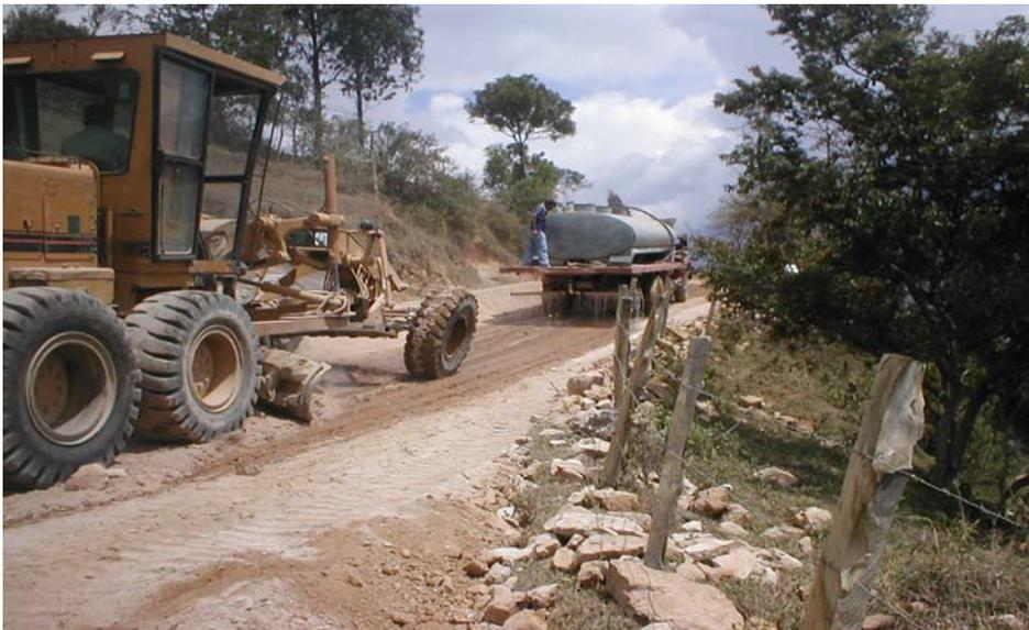
**Foto15. Mezclado de material empleando motoniveladora fase 3**
