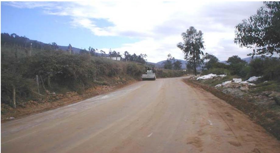
**Foto17. Compactación de la capa en franjas empleando vibrocompactador fase 2**
