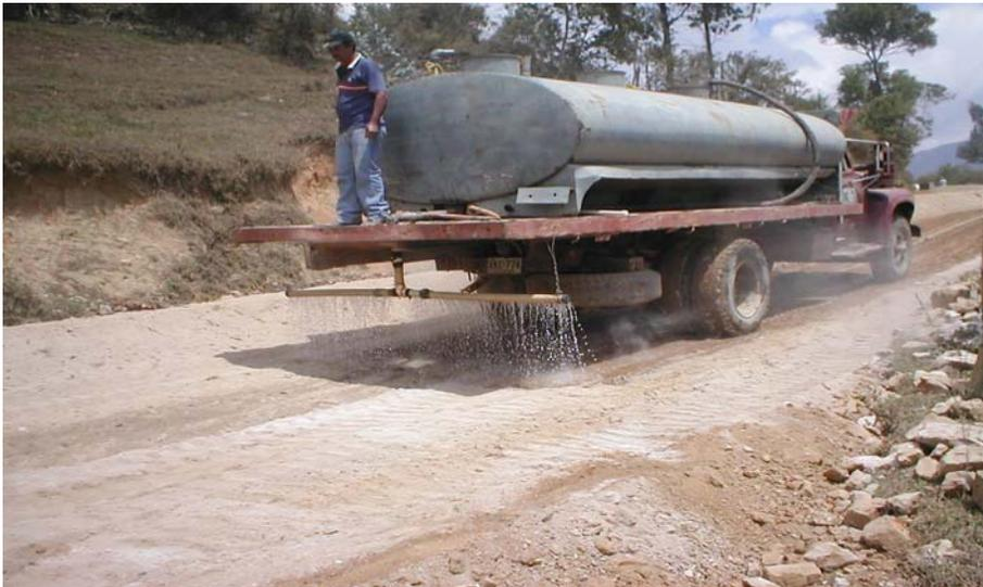
**Foto12. Adición del contenido de agua empleando tanque irrigador fase 2**
