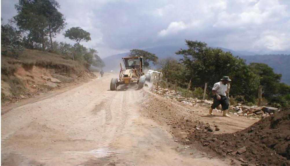
**Foto10. Mezclado del suelo con el aditivo fase 4**
