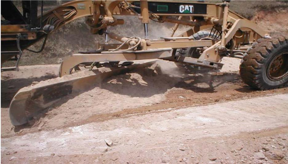
**Foto14. Mezclado de material empleando motoniveladora fase 2**
