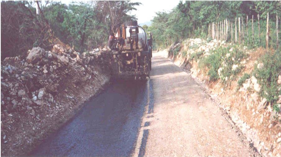
**Foto 20. Slurry-seal**
