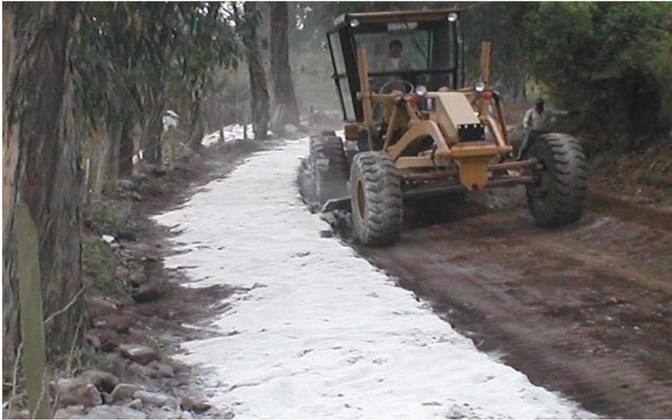
**Foto 8. Mezclado del suelo con el aditivo fase 2**
