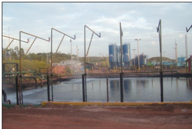
Figura 6. Piscina para tratamiento de aguas.
