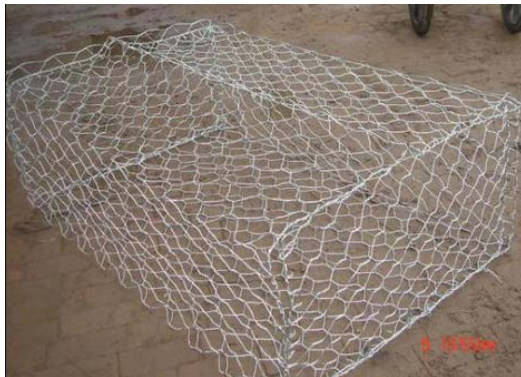
Figura 23. Preparación de la malla del gavión antes de iniciar su llenado.
