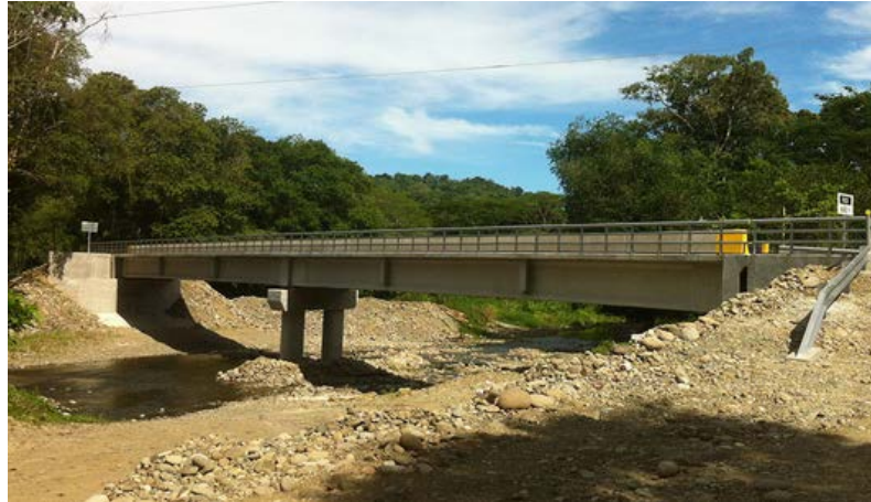
Figura 16. Puente construido con estribos de gravedad de concreto ciclópeo.
