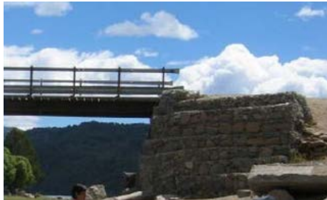
Figura 18. Puente construido con estribos por gravedad de gaviones.
