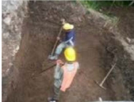
Figura 22. Adecuación del terreno para construcción del estribo de gravedad.
