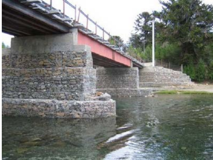
Figura 25. Puente construido con estribos y pilas por gravedad de gaviones
