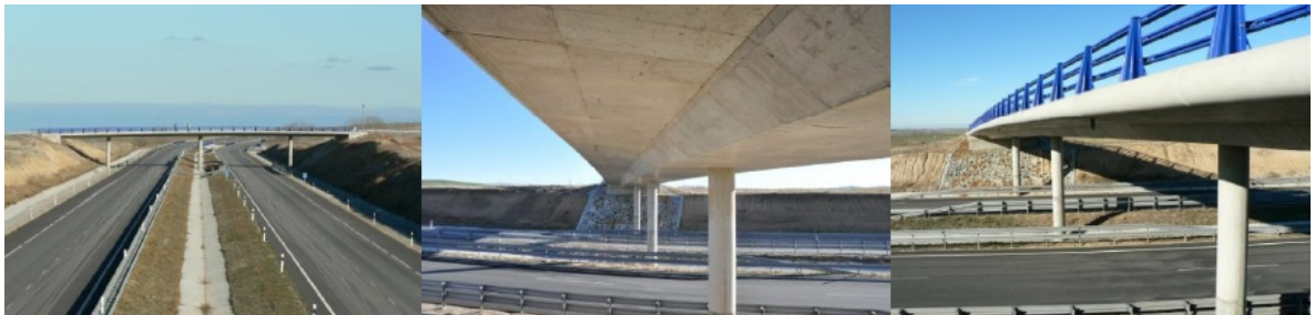
Figura 51. Puente integral instrumentado en la provincia de Ávila, España.
