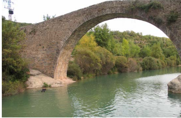
Figura 10. Puente integral construido en piedra.
