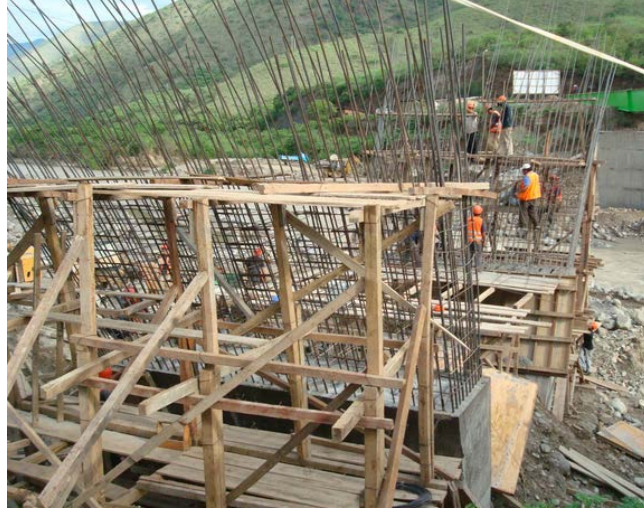
Figura 40. Colocación del armado en un estribo en voladizo.
