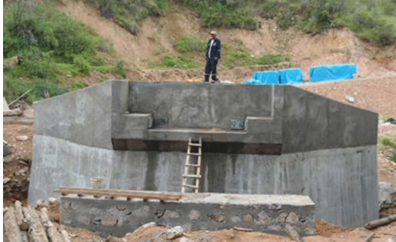
Figura 42. Etapa final de la construcción de un estribo en voladizo.
