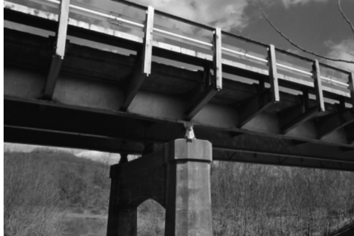
Figura 50. Primer puente de la época moderna construido con principios de integrar la superestructura con la subestructura.
