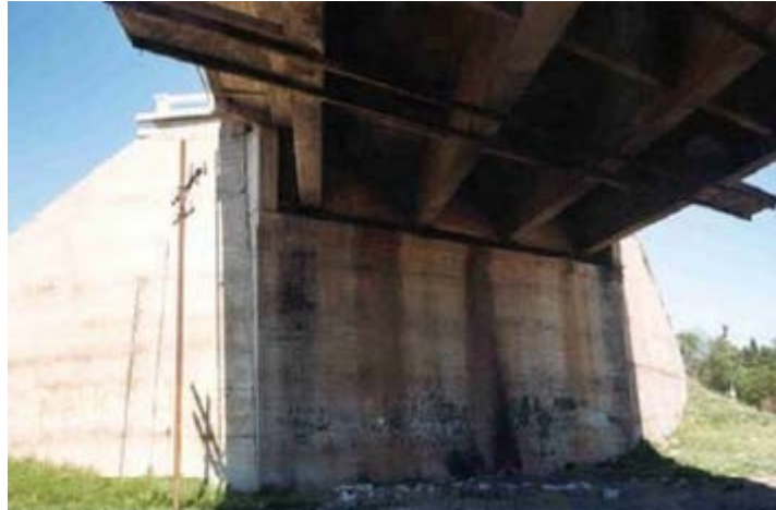
Figura 36. Puente construido con estribos en voladizo.
