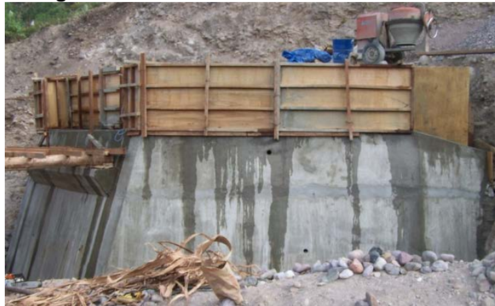
Figura 41. Encofrado de un estribo en voladizo.
