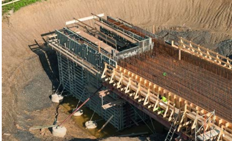
Figura 66. Armado del acero de refuerzo en un puente integral.
