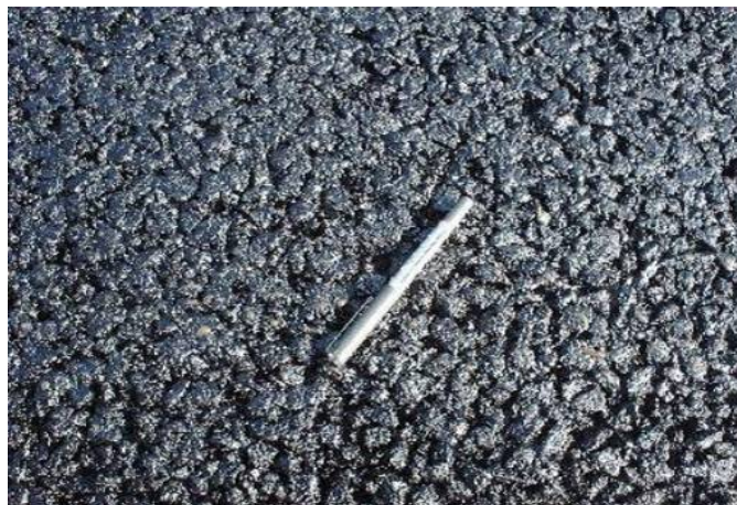
Figura 3 Mezcla SMA en terreno
