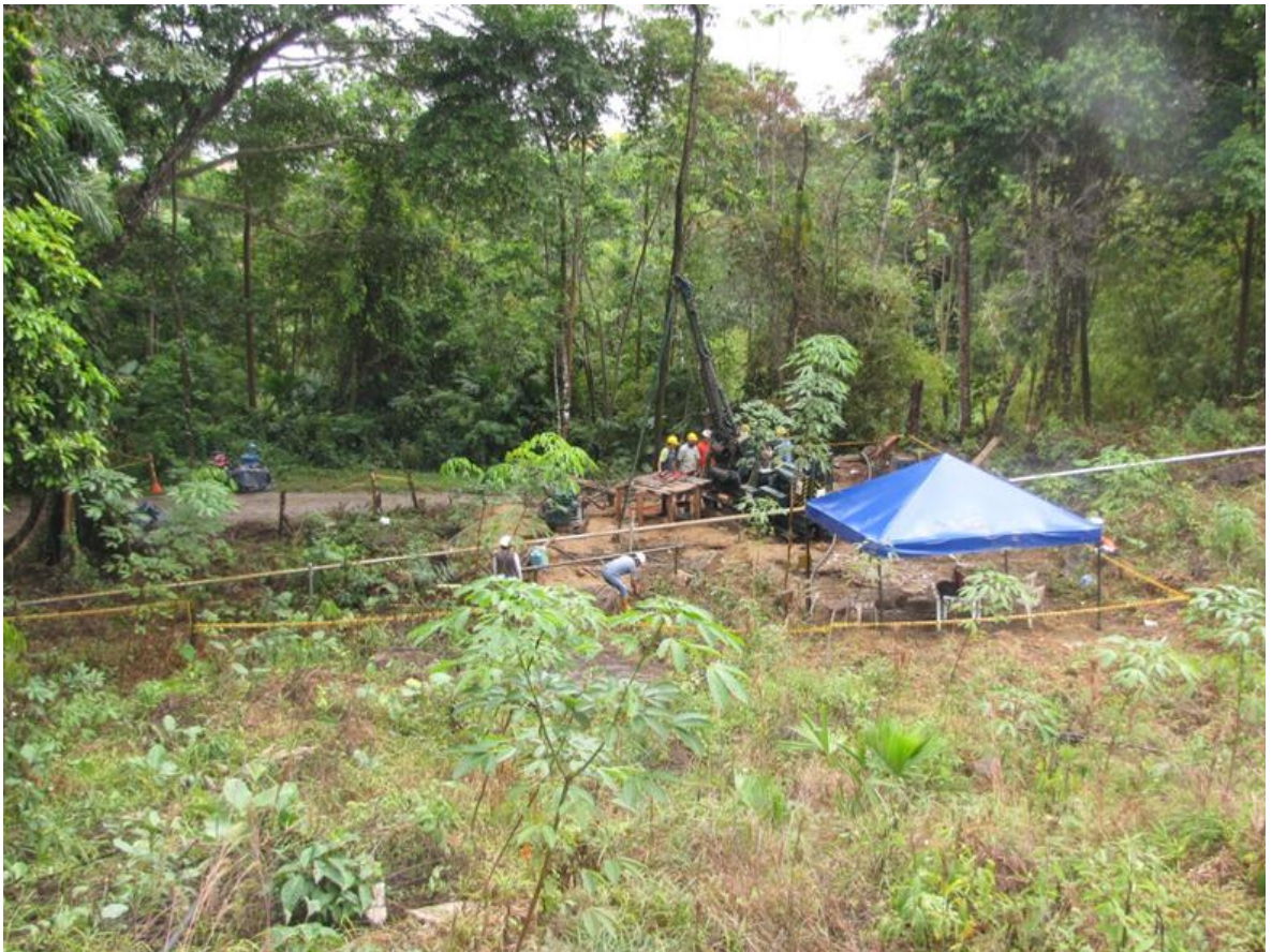
Figura 21. Punto de Perforación No 1 FLG-092-P1, Vereda Tempestuosa.
