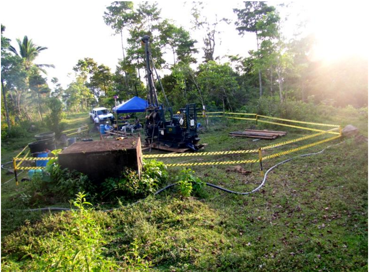
Figura 53. Punto de Perforación No 4 FLG-092-P3 Vereda Tulcán-EI Diamante.
