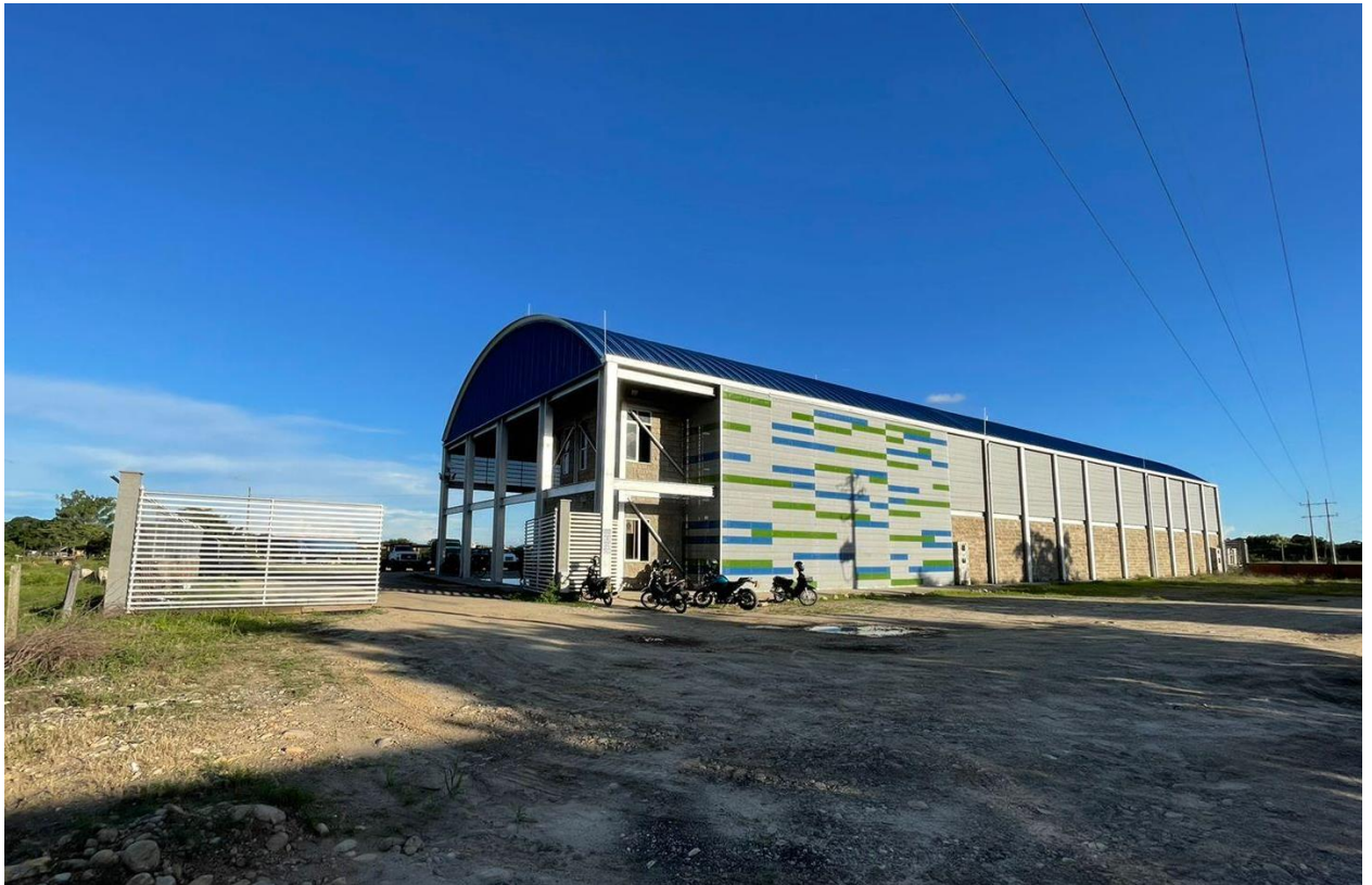
Figura 2. Taller de obras públicas de la Gobernación de Casanare
