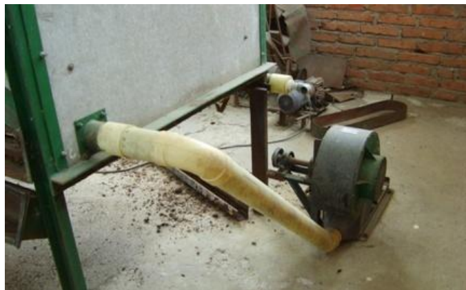
Foto 14. Sistema de inyección de aire. Fuente: el Autor.
