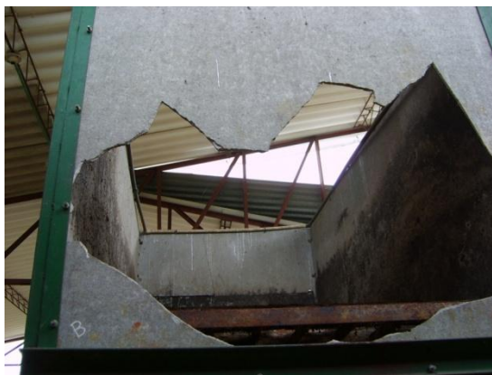
Foto 12. Paredes del bio-reactor. Fuente: el Autor.
