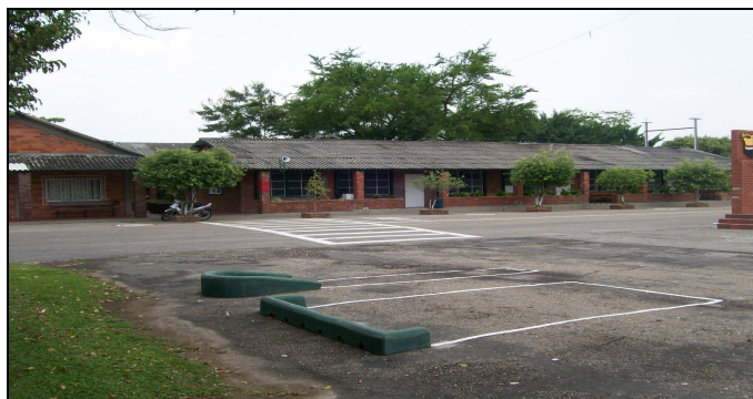
Figura 7. Vista Externa del Colegio El Rosario.
