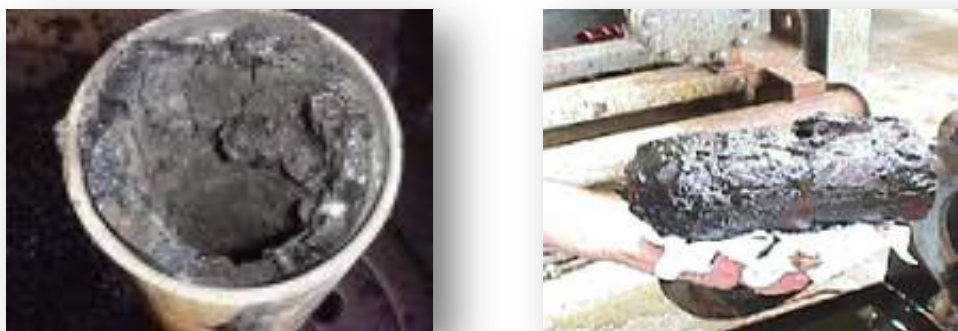
Figura 3. Cambio de la Tubería de Producción por Asfaltenos
