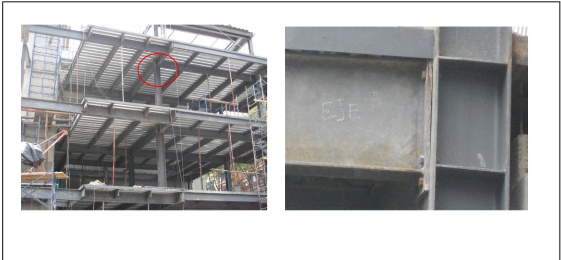
**Sistema constructivo:** Estructura de 4 pisos. Pórticos de acero a momento en ambas direcciones.
