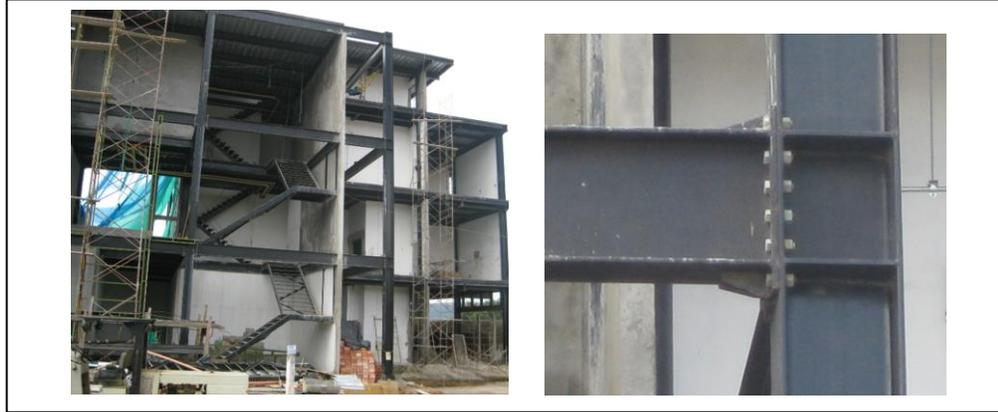
**Sistema constructivo:** Pórticos de acero a momento en las dos direcciones.
