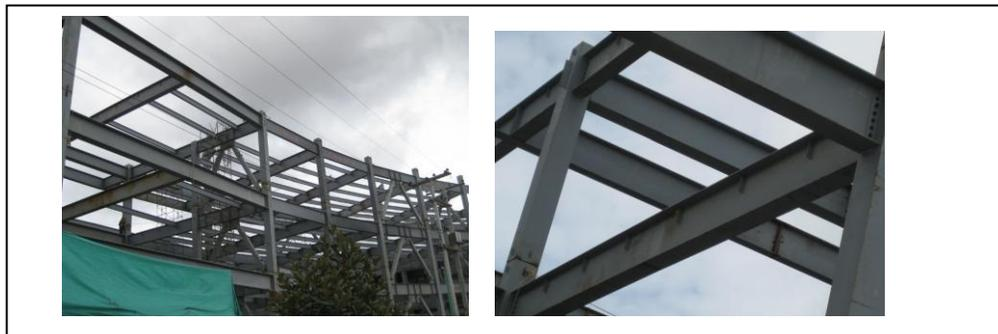
**Sistema constructivo:** Pórticos de acero estructural con diagonales concéntricas en las dos direcciones.
