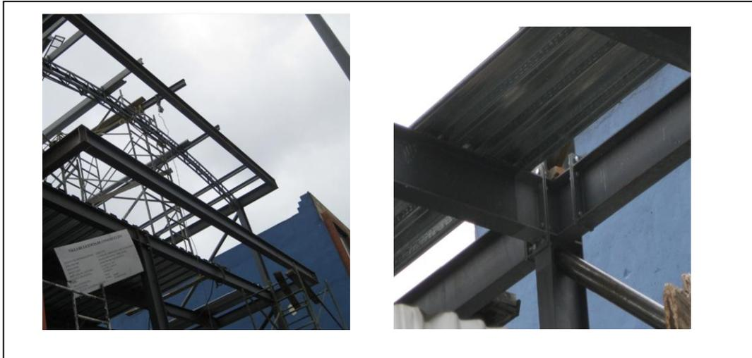
**Sistema constructivo:** Estructura de 3 pisos. Pórticos de acero a momento arriostrados dirección longitudinal y pórticos a momento en dirección transversal.
