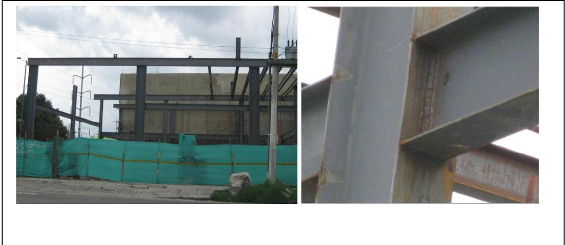
**Sistema constructivo:** Pórticos de acero a momento en las dos direcciones principales.
