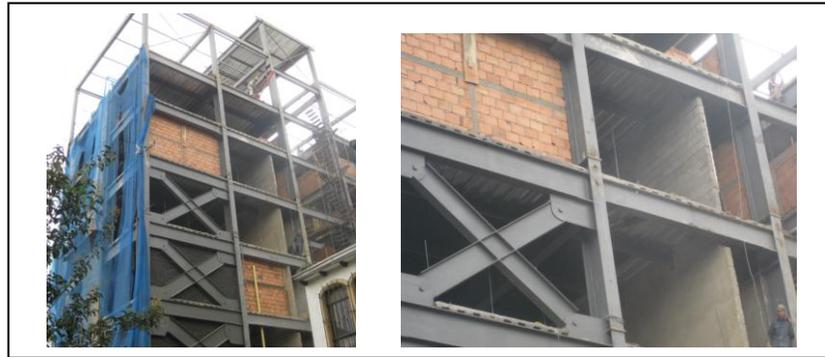
**Sistema constructivo:** Pórticos de acero a momento en la dirección fuerte de las columnas y pórticos con arriostramientos en dirección débil de las columnas hasta el tercer nivel y para los pisos superiores pórticos a momento.
