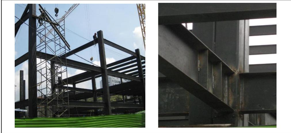
**Sistema constructivo:** Pórticos de acero a momento en las dos direcciones principales.
