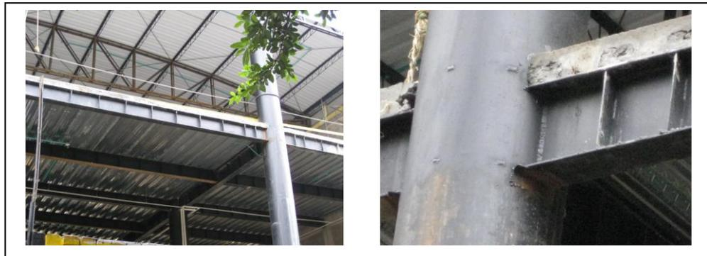
**Sistema constructivo:** Pórticos de acero a momento en las dos direcciones principales.
