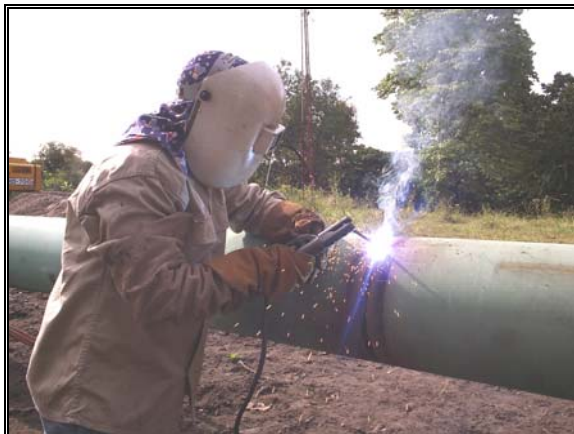
Foto 1.7. Soldadura de juntas.
