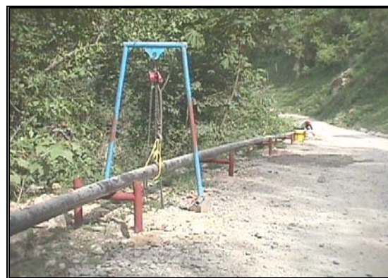
Foto 1.17. Marcos “H” instalados para una línea de flujo.
