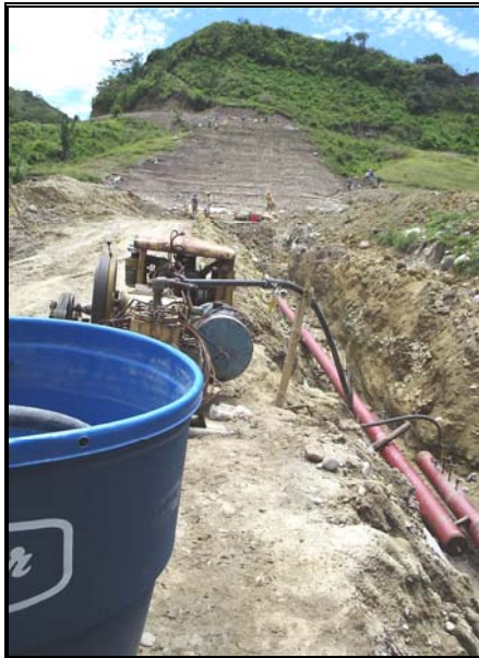
Fotos 1.19 a 1.21. Prueba hidrostática.
