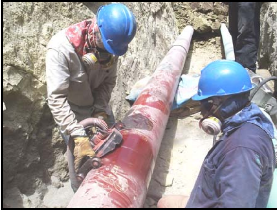
Foto 1.12. Recubrimiento anticorrosivo de juntas.
