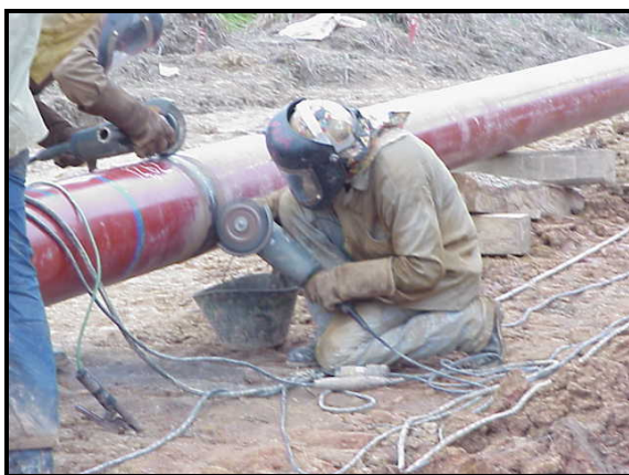
Foto 1.10. Esmerilado de juntas soldadas.
