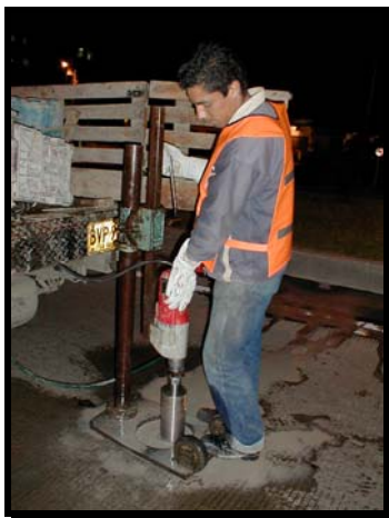
Figura 40. Toma de núcleos vía en concreto para transporte masivo (transmilenio)
