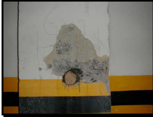
Figura 42. Relleno con mortero de una cavidad después de la extracción de un núcleo
