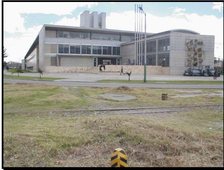
Figura 57 Edificio con muros en mampostería estructural
