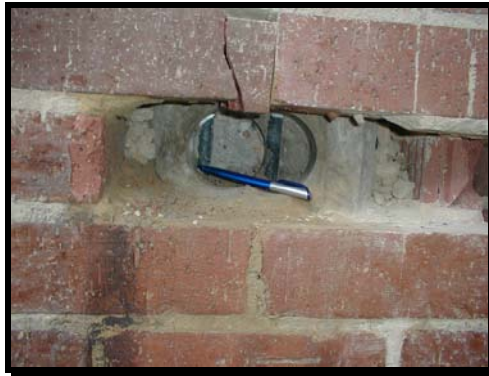
Figura 65 Extracción de elementos de mampostería para ensayos de compresión.
