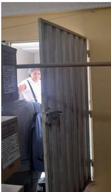
Ingreso al archivo histórico, chapa simple y palo utilizado para dar soporte a estantería
