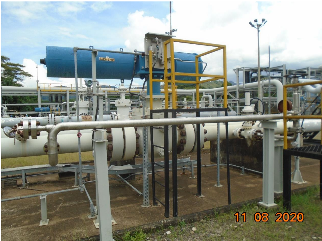
Figura 17. Válvula de parada de seguridad SDV
