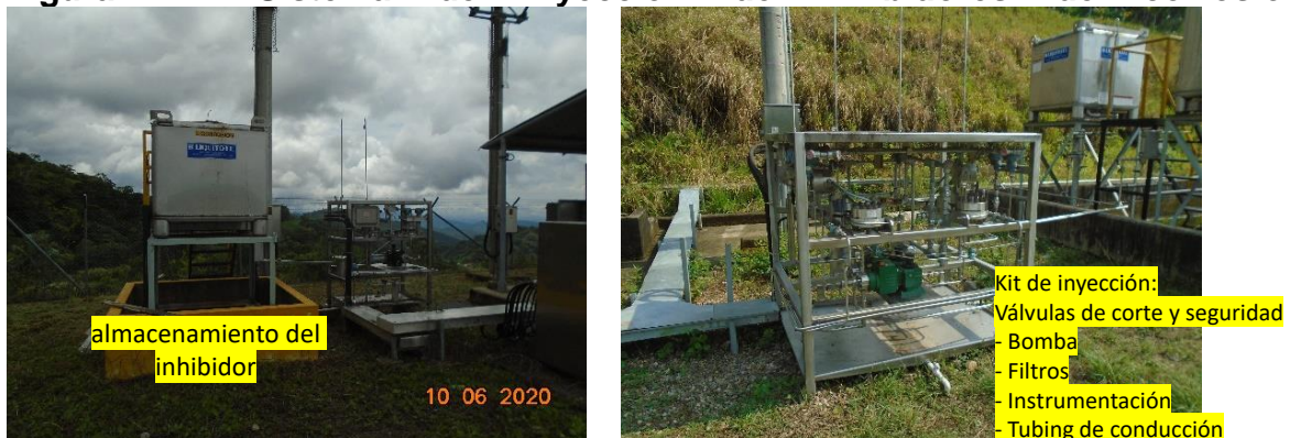
Figura 21. Sistema de inyección de inhibidores de corrosión
