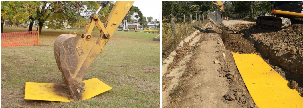
Figura 29. Placas plásticas para protección de sistemas enterrados en zonas de alta consecuencia
