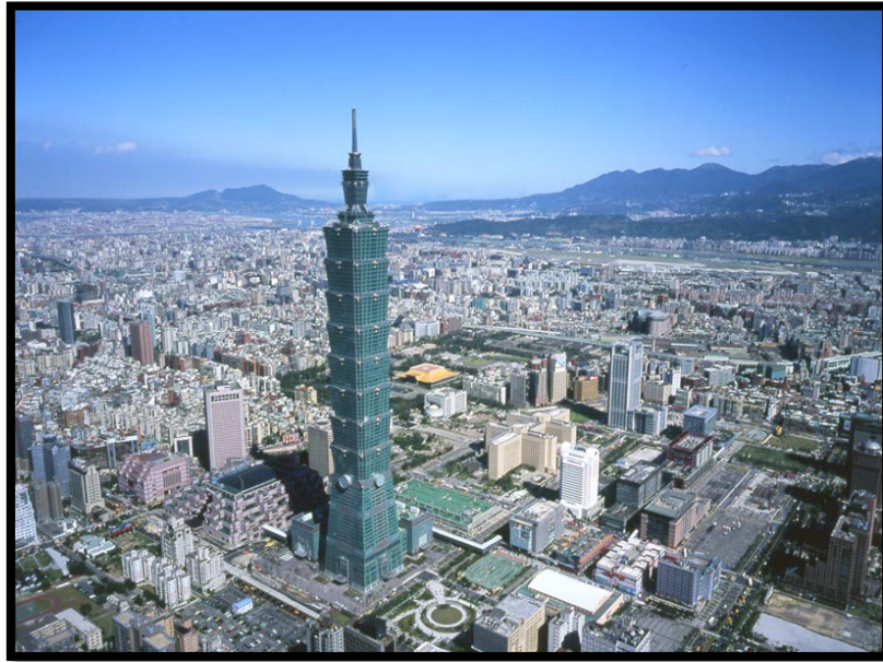
Figura 6. Panorámica del Taipei 101 sobre la ciudad de Taipei
