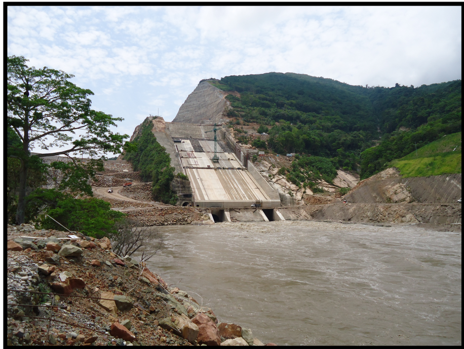
Figura 27. Etapa de Construcción del embalse. (Marzo 26-2012)
