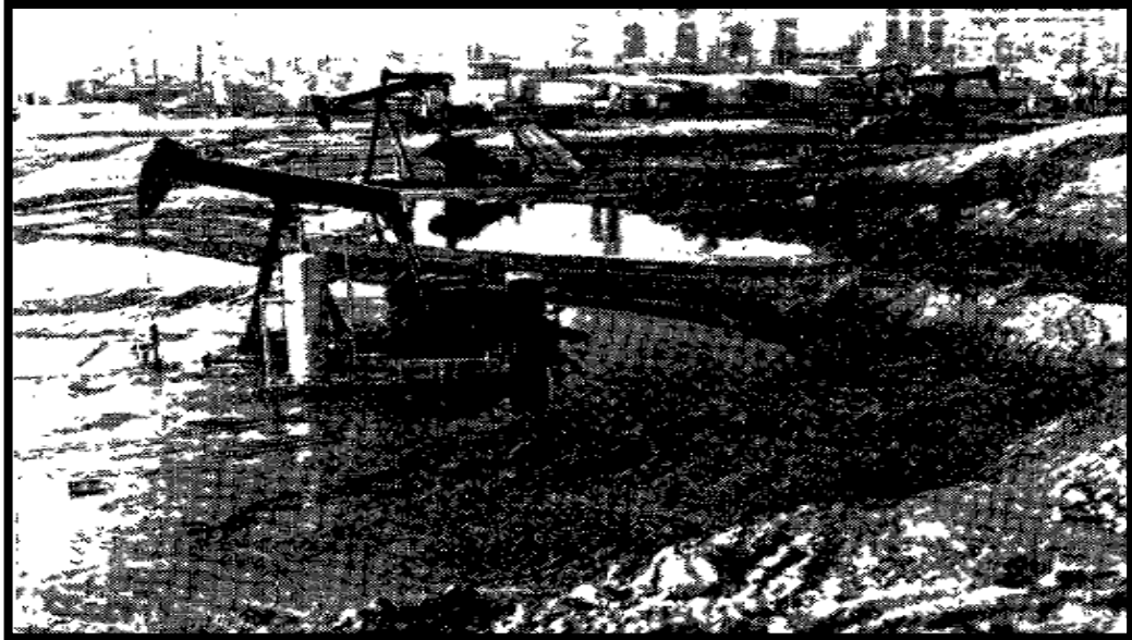
Figura 46. Consecuencia de la subsidencia en los campos de petróleo.
