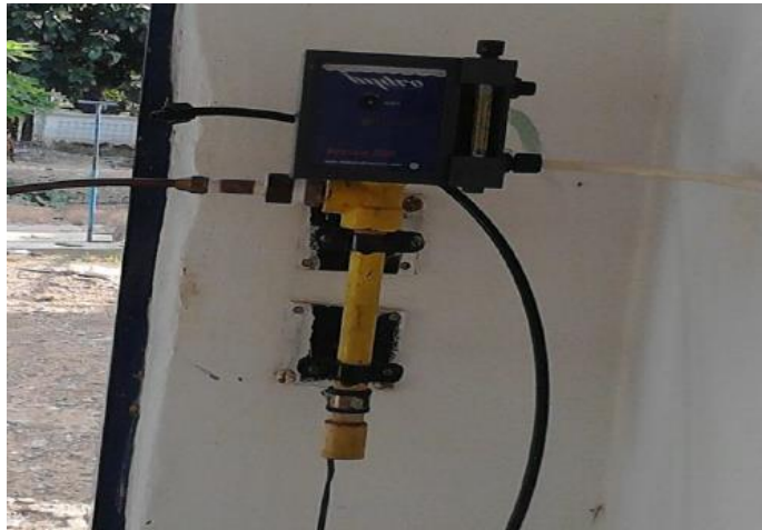
Figura 14. Dosificador de cloro (APCES E.P.S)
