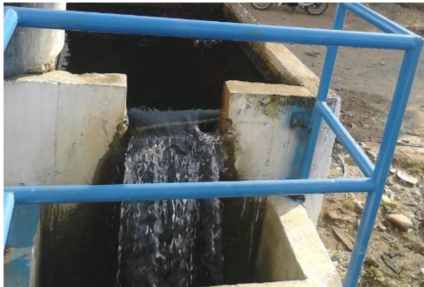
Figura 8. Medidor de caudal (APCES E.P.S).
