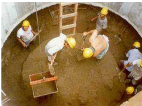
Figura 42. Pozo de cimentación para un puente.
