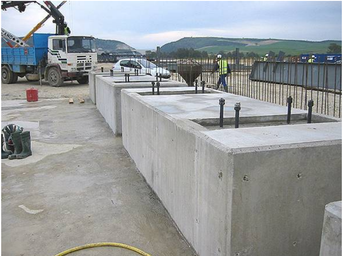
Figura 43. Cimentación de máquinas.
