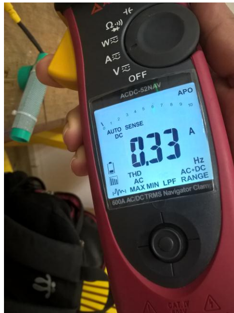
Figura 16. Parámetros de operación de la celda generadora de ozono.
