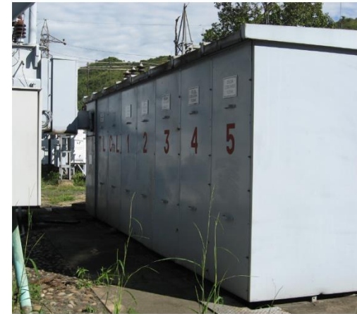
Trenes de celdas de 13,8kV asociadas a las salidas de circuito y enlace del lado de baja del Transformador T-2
