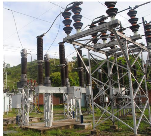
Equipos de la Bahía de transformación asociada al lado de alta del Transformador T-1
