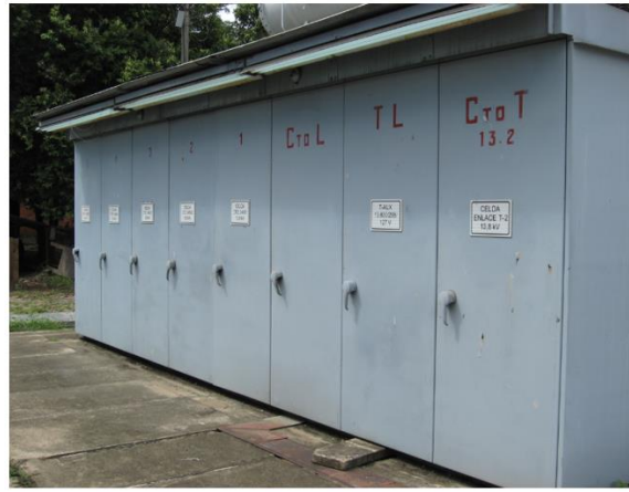
Trenes de celdas de 13,8kV asociadas a las salidas de circuito y enlace del lado de baja del Transformador T-2
