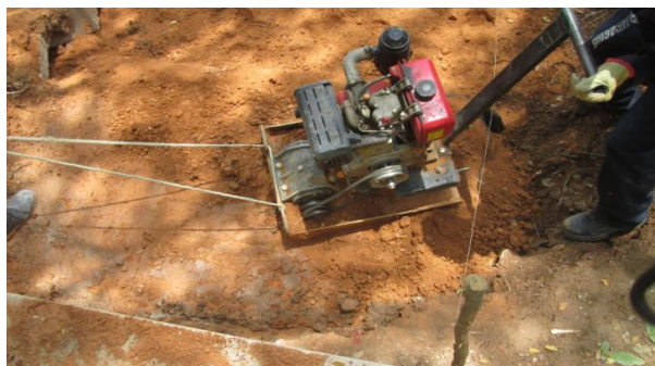
Figura 9. Relleno y compactacion para mejoramiento de soporte de suelo
