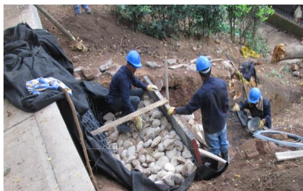
Figura 11. Mejoramiento de suelo de soporte para escaleras.
