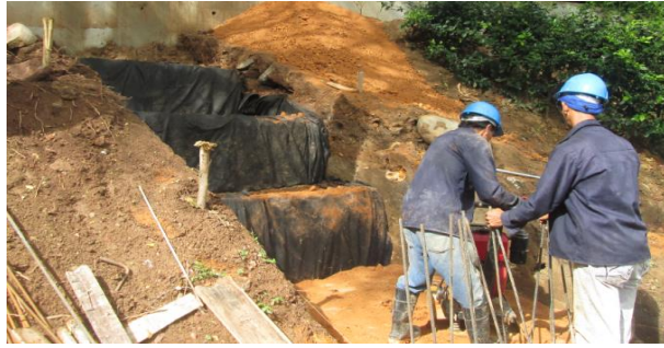
Figura 12. Vertido de concreto de 3000PSi.
