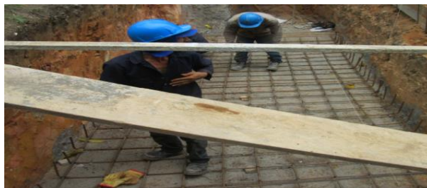
Figura 8. Armado de aceros de refuerzo
