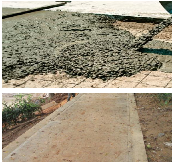
Figura 10. Vertido de concreto de 3000 psi.
