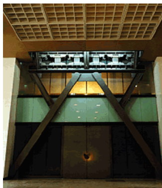
Figura 8. Fotografías, derecha sistema de arriostramiento dúctil, derecha amortiguador de tipo viscoso.
