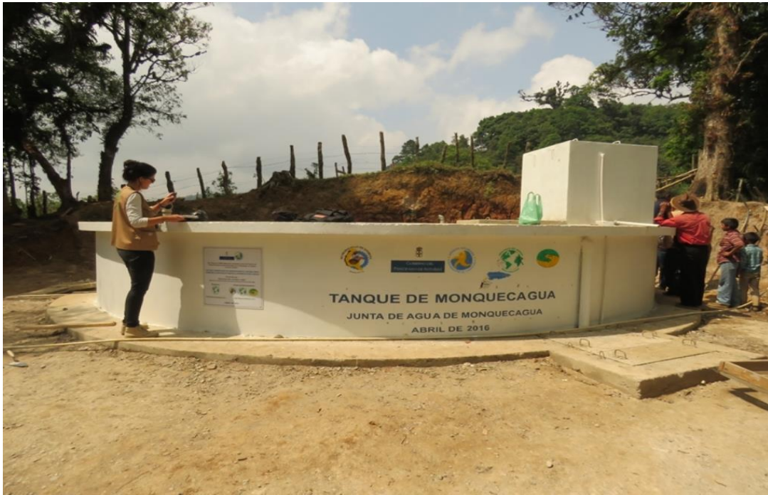
Figura 4. Tanque de almacenamiento de agua semienterrado con configuración cilíndrica. Adaptado Dexeologos del mundo. (2015). Tanque de Monquecagua. Disponible en: http://www.xeologosdelmundu.org/wp-content/uploads/2015/01/22-1.jpg
