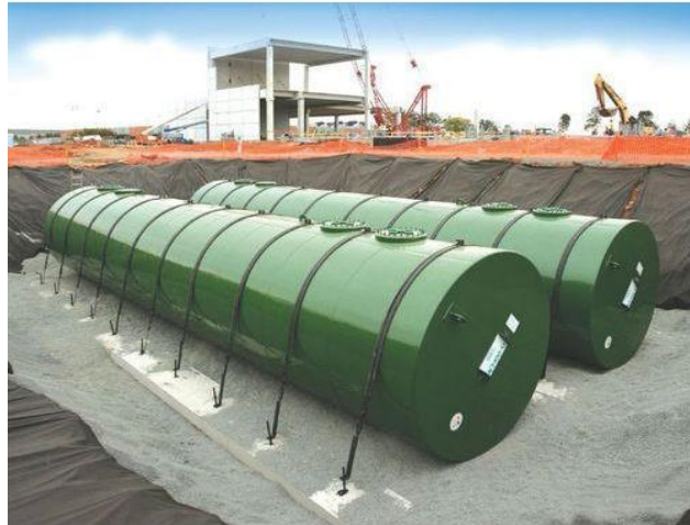
Figura 1. Tanque de almacenamiento de agua subterráneo con configuración cilíndrica. Adaptado de Indiamart. Water storage tank. Disponible en: https://www.indiamart.com/proddetail/underground-water-storage-tank-19739040155.html
