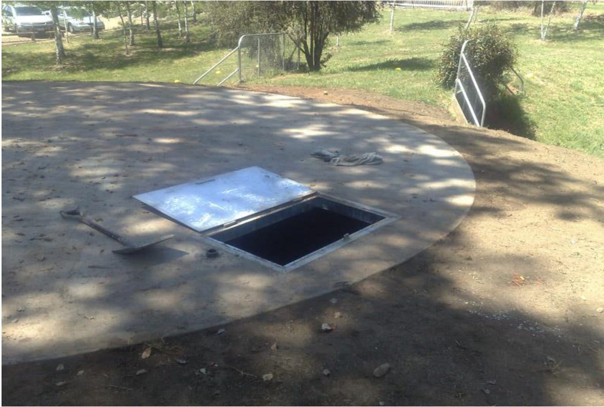
Figura 5. Tanque de almacenamiento de agua enterrado con configuración cilíndrica. Adaptado de Advance Concrete Tanks. (sf). Concrete Tank Construction. Disponible en: http://www.advanceconcretetanks.com.au/concrete-tank-construction.php
