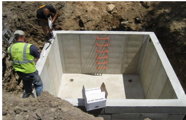
Figura 2. Tanque de almacenamiento de agua subterráneo con configuración rectangular. Adaptado de Indiamart. Water storage tank. Disponible en: https://www.indiamart.com/proddetail/underground-water-storage-tank-19739040155.html
