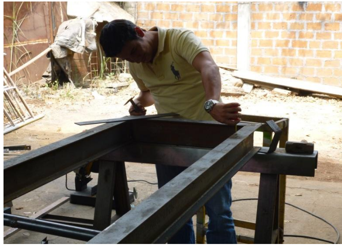
Figura 47. Contrucción de la estructura base.
