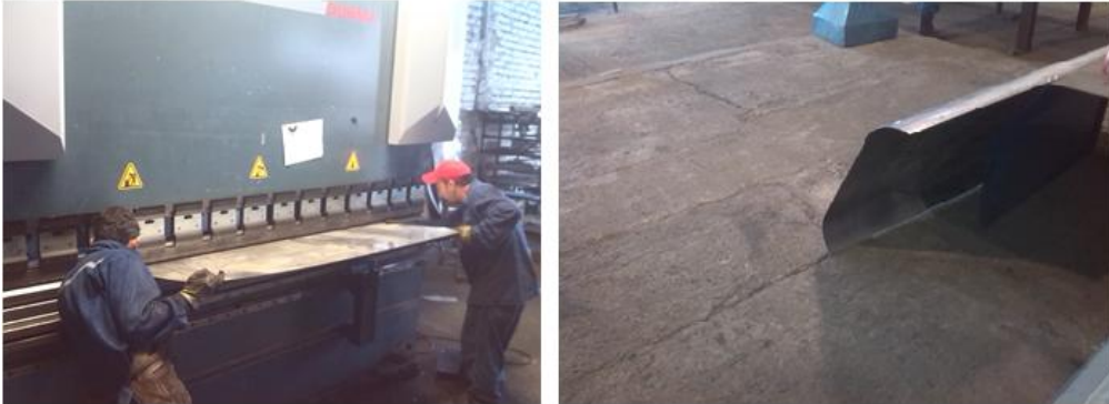
Figura 58. Precurvado de la lámina de acero
