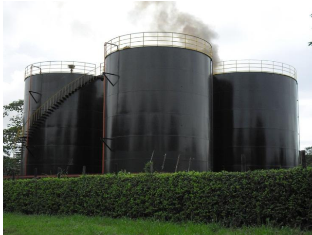
Figura 20. Tanques para almacenamiento de aceite rojo de palma y aceite de palmiste
