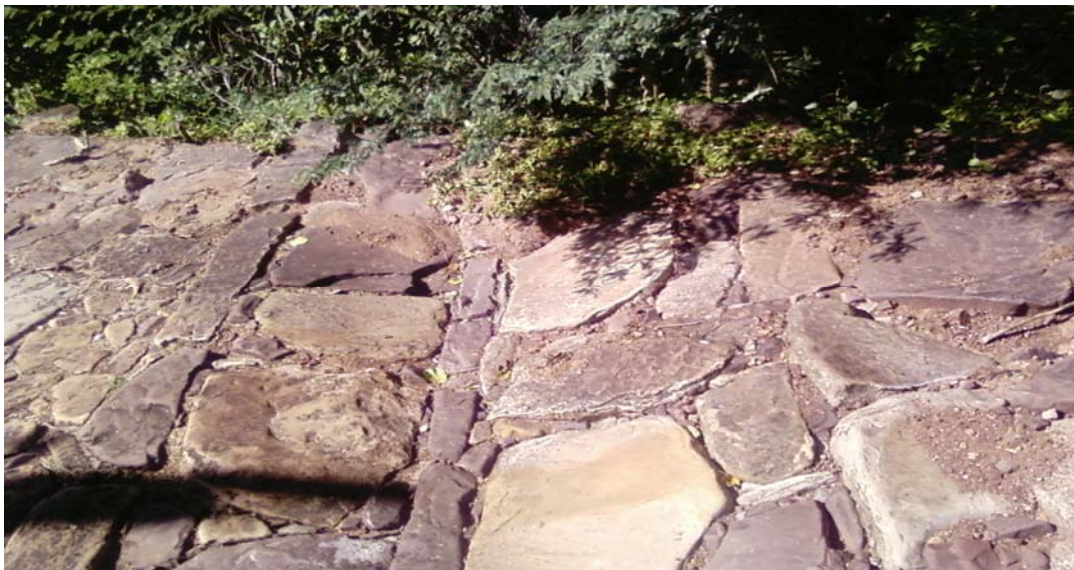
Figura 5. Batea de desagüe ubicada en el camino Los Santos-Jordán sube
