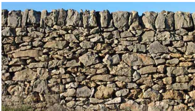
Figura 4. Muro típico de piedra "seca"
