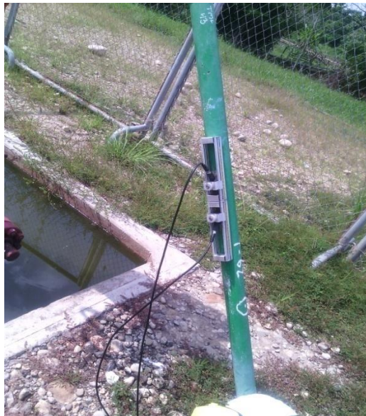
Figura 40. Toma de caudales pozo inyector
