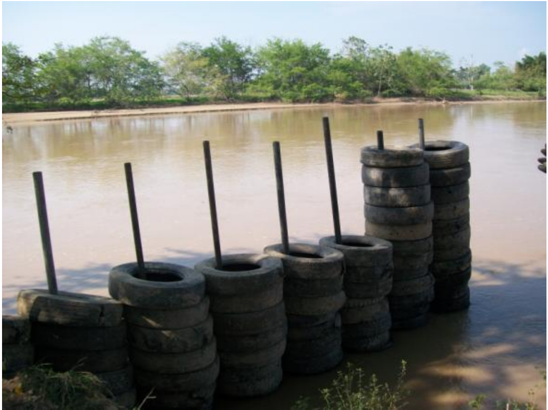
Figura 25. Colocación de llantas en el espigón Samarcanda
