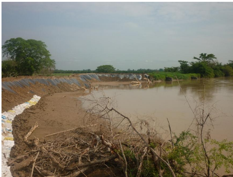
Figura 30. Puerto Arturo Febrero 25. Dos espigones construidos
