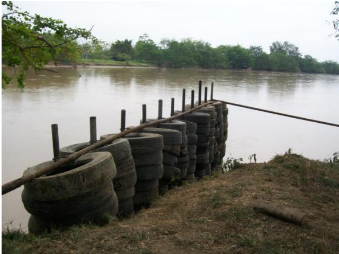
Figura 26. Instalación de tubo horizontal espigón Samarcanda
