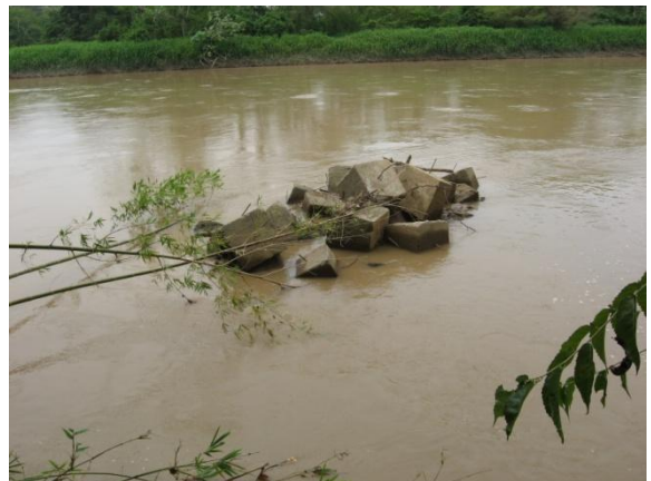
Figura 8. Situación actual, protección de la margen de derecha aguas abajo, finca Puerto Arturo.
