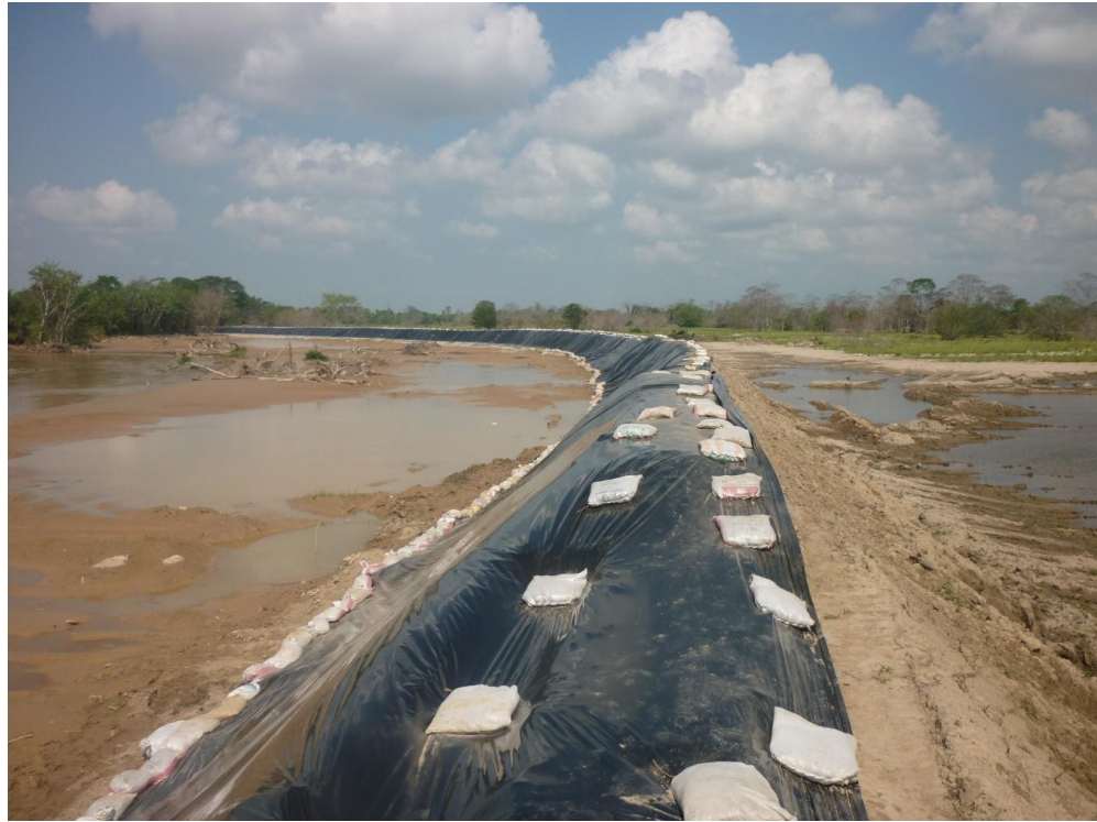
Figura 41. Geotextil sobre muralla o jarillón
