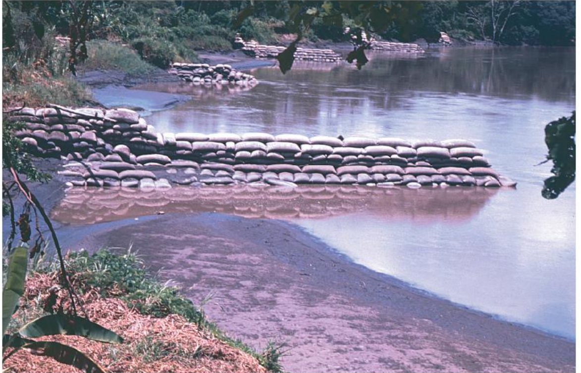
Figura 35. Espigones en bolsamortero y/o bolsacreto
