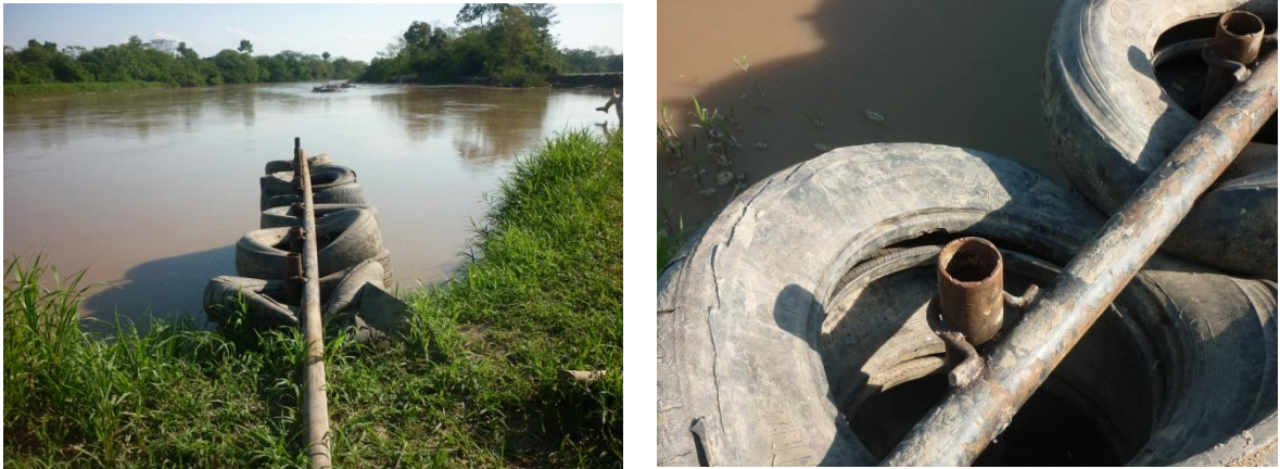
Figura 23. Espigones de llantas y tubería de perforación
