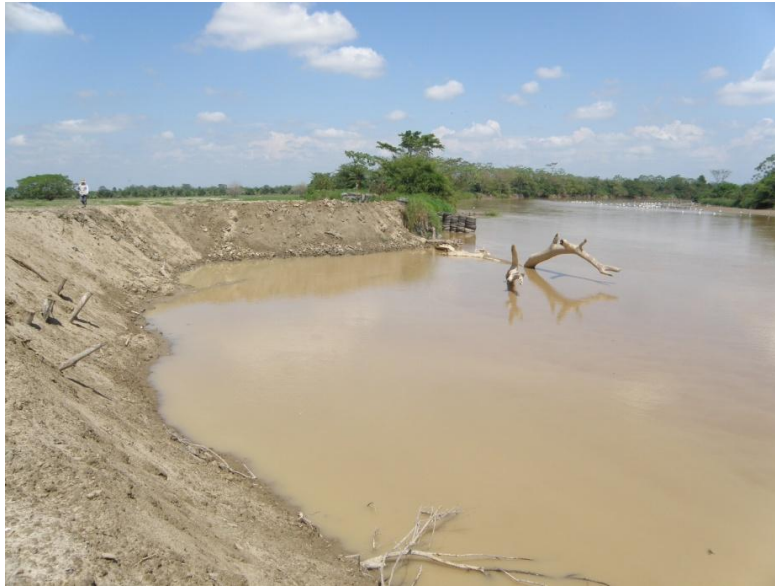
Figura 29. Puerto Arturo Febrero 2. Dos espigones construidos
