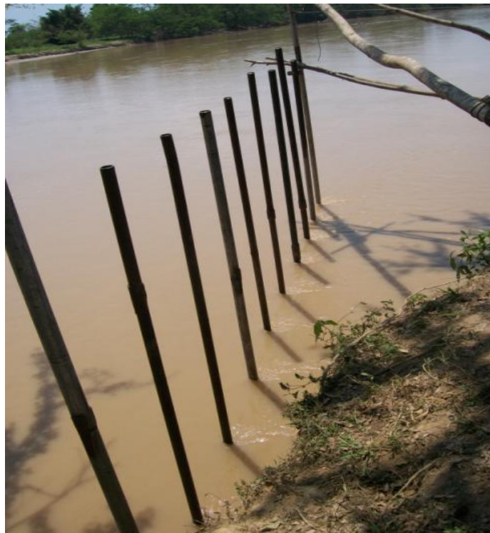
Figura 24. Instalación de tubería de perforación en el río Samarcanda
