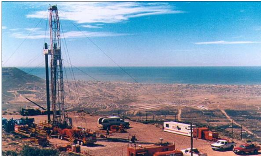
Figura 1. Instalación de una Torre de Perforación.
