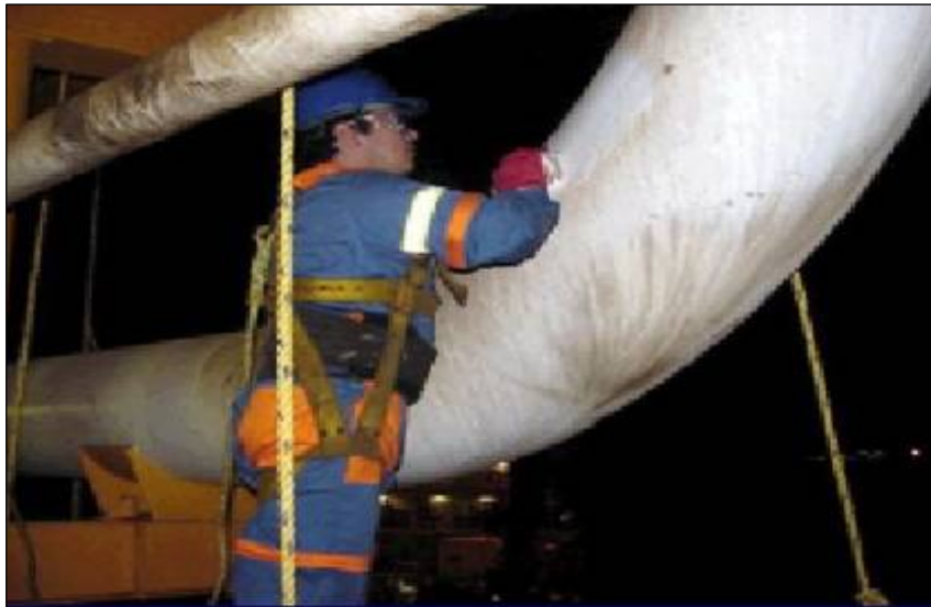
Figura 6. Inspección visual de un Oleoducto.
