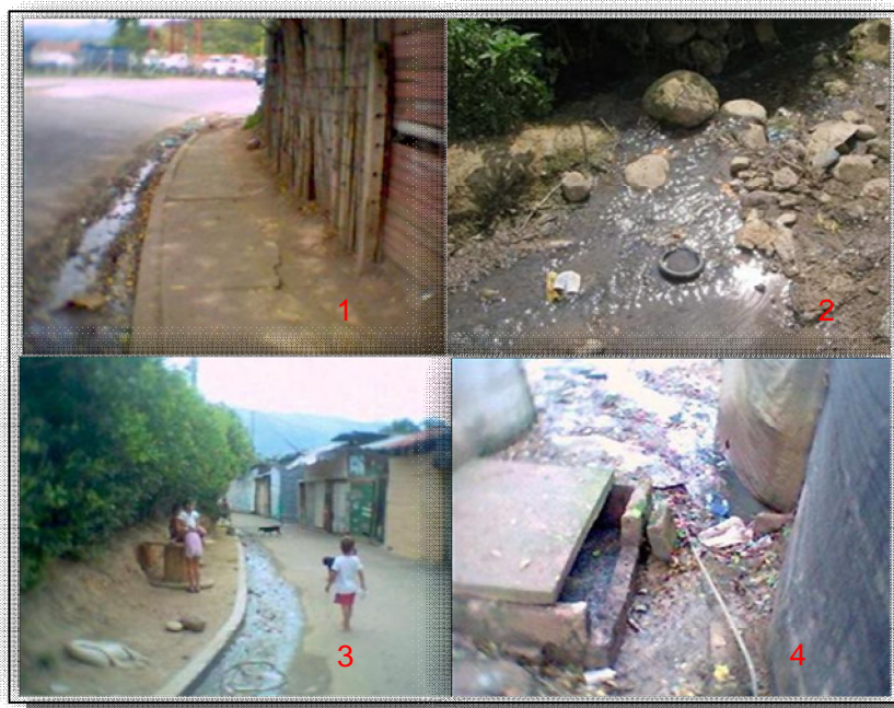
Fotografía 3 - Percolación de aguas negras en La Estanzuela (1); acumulación de aguas lluvias en Altos de Andina - Girón (2) por ausencia de Alcantarillado; Aguas de residuo en las vías de los asentamientos Colinas de La Meseta, Villa de Paz y Valle de Los Caballeros - Girón (3) y, Tanque de almacenamiento de aguas negras de Convivir - Girón (4).
