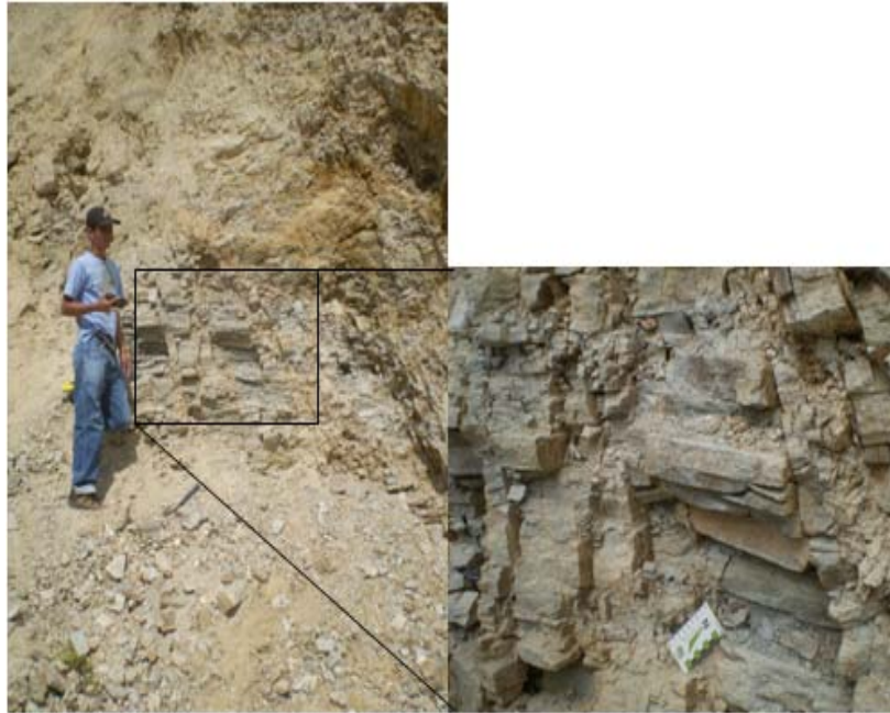
Figura 34: Gneis con alto grado de fracturas; la figura ilustra el grado de fracturamiento y diaclasamiento producto de esfuerzos generados sobre la falla mensulí.
