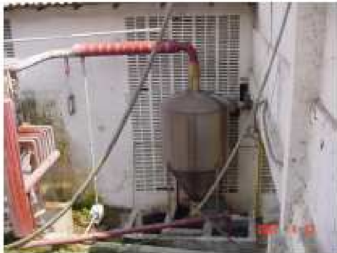
Lugar de montaje del intercambiador de calor.
