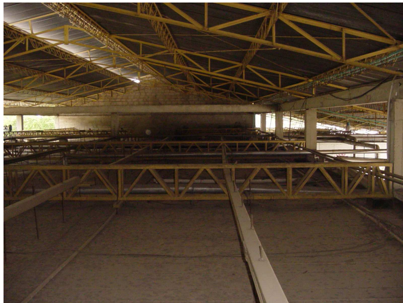
Figura 6. Instalaciones eléctricas e hidráulicas sobre el techo.
