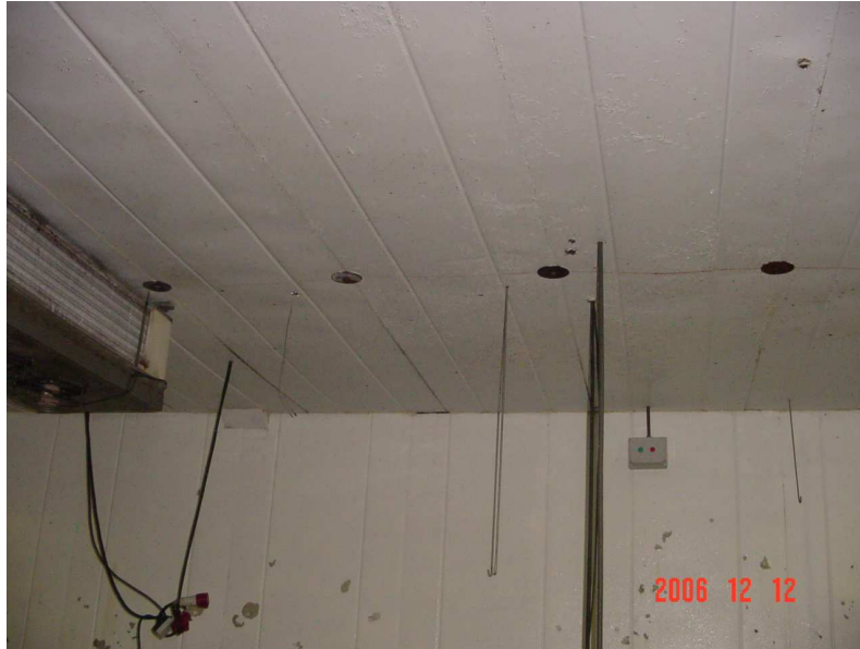
Figura 3. Techo del salón de post-proceso
