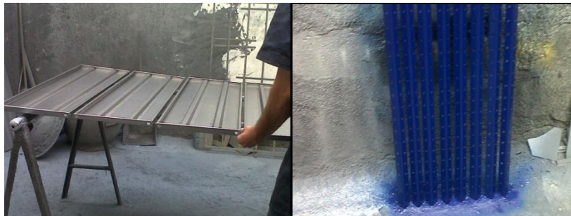
Figura 11. Proceso de pintura de bandejas y parales.
