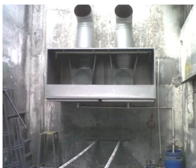
Figura 61. Extractor de olores y partículas para el área de pintura.
