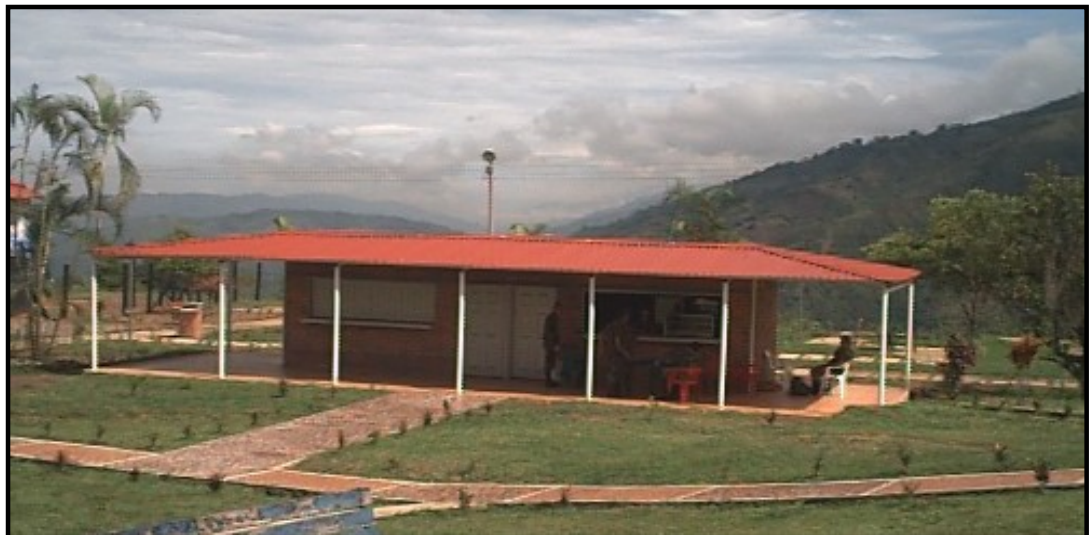
Figura 17. Cubierta en teja thermoacustic a cuatro aguas.
