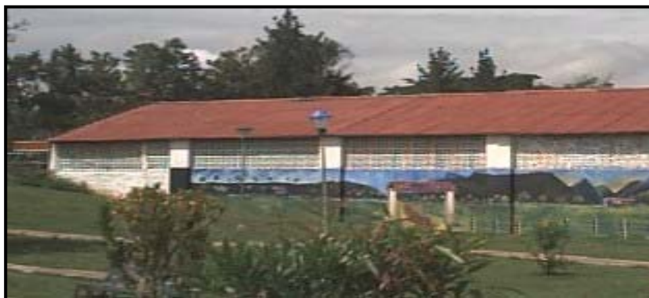
Figura 20. Cubierta teja asbesto cemento dos aguas.
