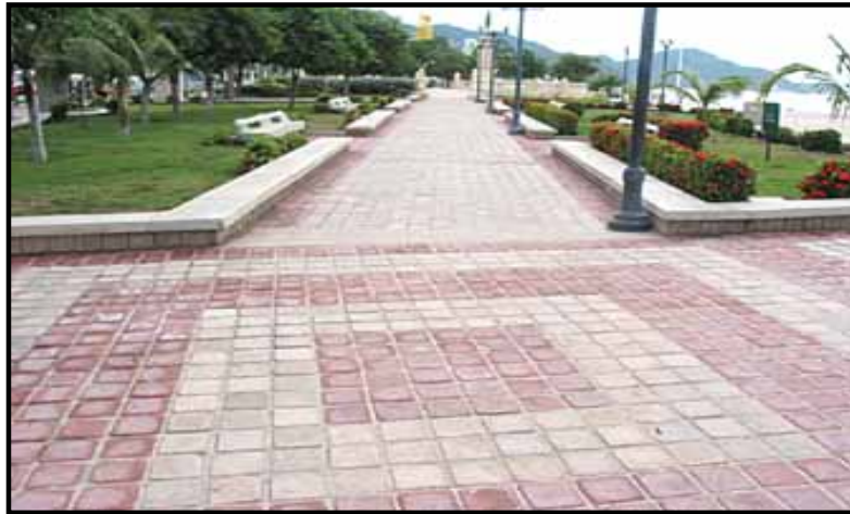
Figura 3. Peatonal en piso Adoquinado.
