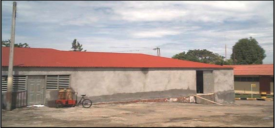
Figura 18. Cubierta en teja thermoacustic a dos aguas.
