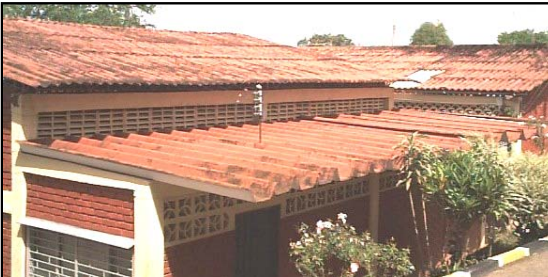
Figura 23. Cubierta canaleta asbesto cemento.
