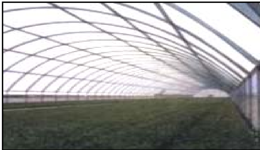
Figura 22. Cubierta teja translúcida
