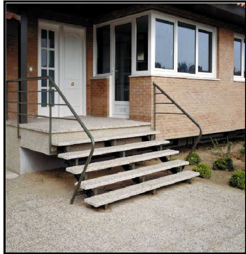
Figura 10. Zonas exteriores y escaleras acabadas en gravilla lavada.
