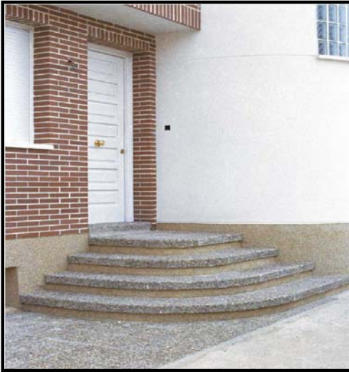
Figura 10. Zonas exteriores y escaleras acabadas en gravilla lavada.
