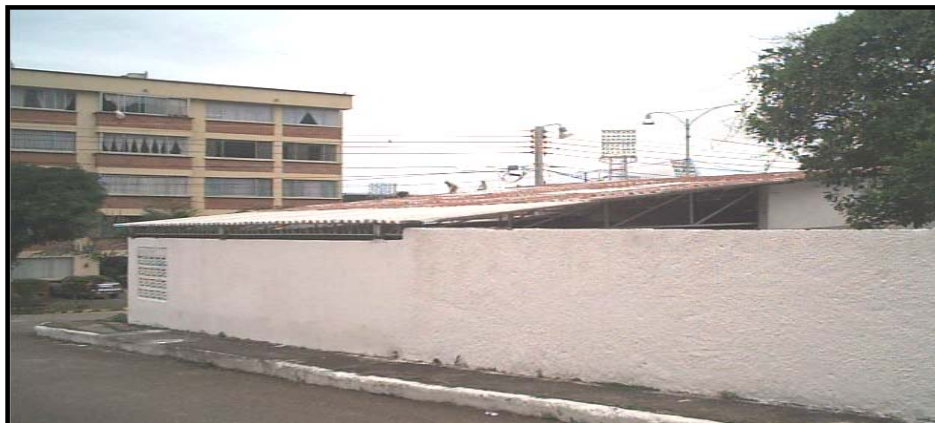
Figura 21. Cubierta teja asbesto cemento un agua.
