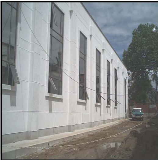
Figura 28. Fachada tipo abujardado.
