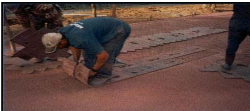
Figura 5. Aplicación de texturas concreto estensilado.
