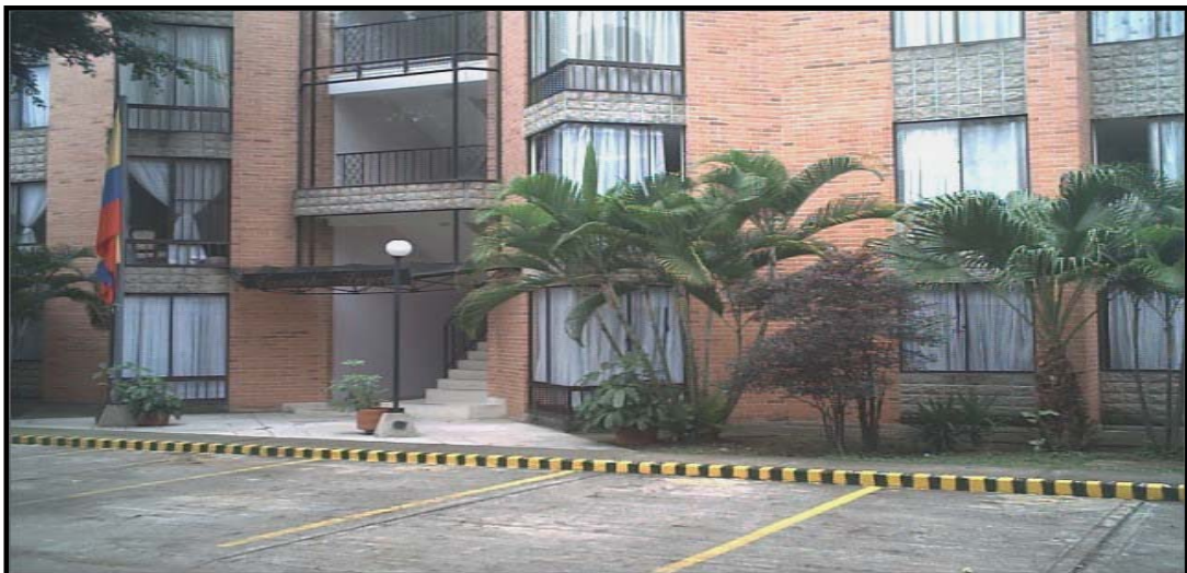
Figura 27. Fachada ladrillo a la vista.
