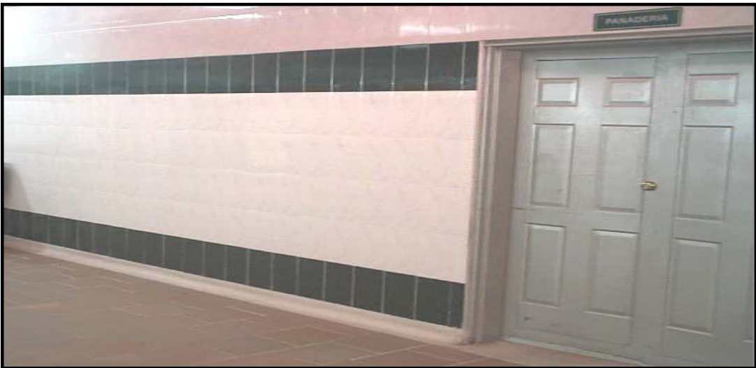
Figura 34. Pared cocina en enchape cerámico.
