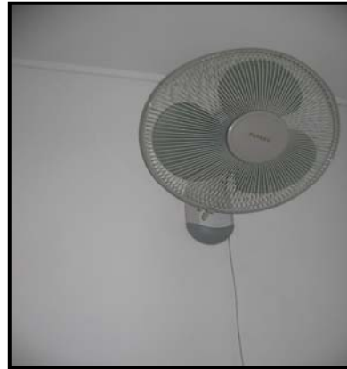
Adecuación de sistemas de ventilación en el área comercial
