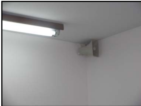
Mejoramiento iluminación consultorio
