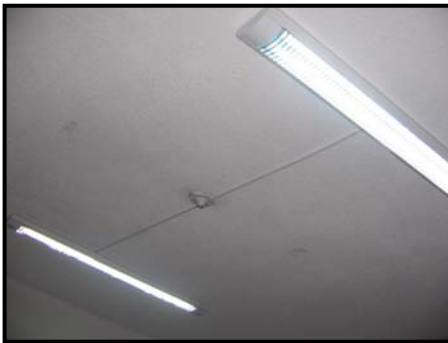
Primer piso Zona de bodega
