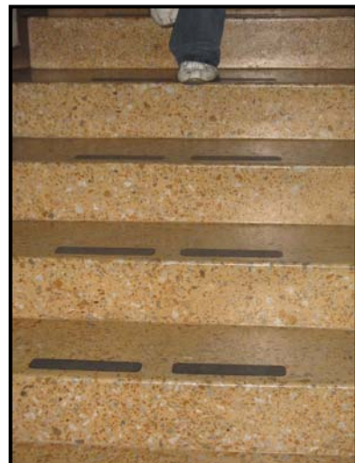
Ubicación de bandas antideslizantes acceso al primer piso
