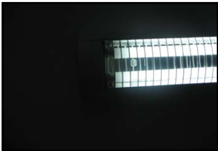
Mantenimiento de luminarias Área comercial
