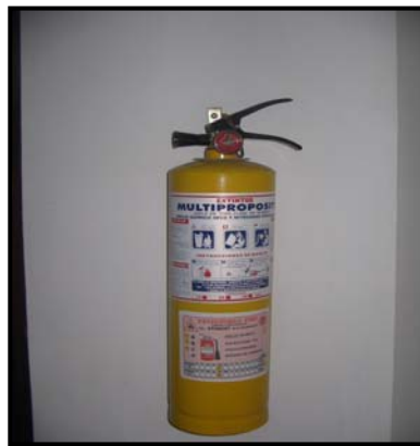
Primer piso Zona común pasillo
