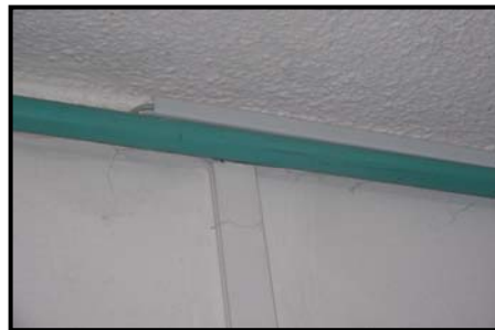
Primer piso zona común pasillo
