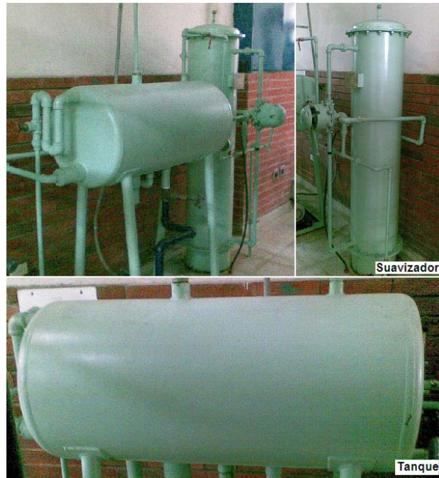
Figura 53. Circuito de Tratamiento de agua
