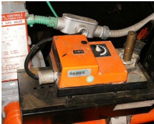
Figura 20. Servo Válvula de control proporcional de gas.
