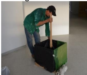
Fig. 14 Construcción de cubos en la técnica de la tapia pisada.
