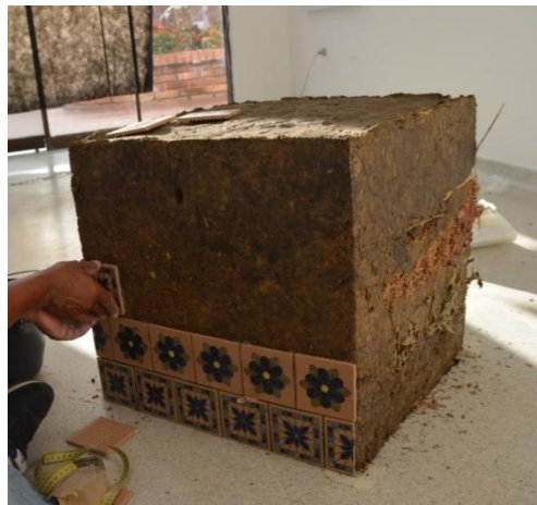
Fig. 14 Construcción de cubos en la técnica de la tapia pisada.
