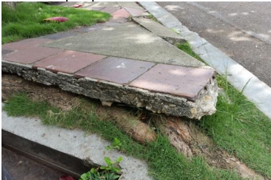
Fig. 3 Fotografía de andén levantado por la fuerza de la raíz desarrollada en un parqueadero de la UIS
