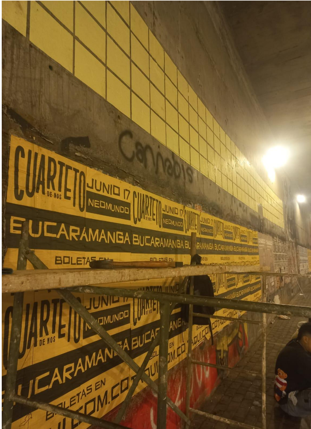
Nota. Registro fotográfico proceso del montaje.
