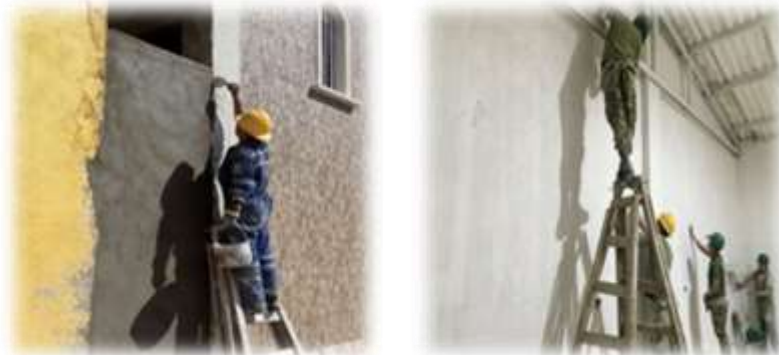
Figura 14. Trabajos de frisado y pintura en interior y exterior de iglesia
