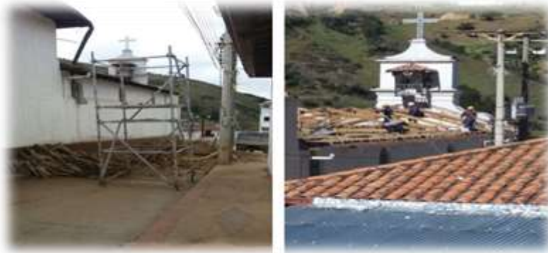
Figura 10. Trabajos de desmantelamiento de antigua cubierta
