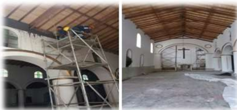
Figura 12. Trabajos de mampostería y pintura en paredes y carpintería de madera
