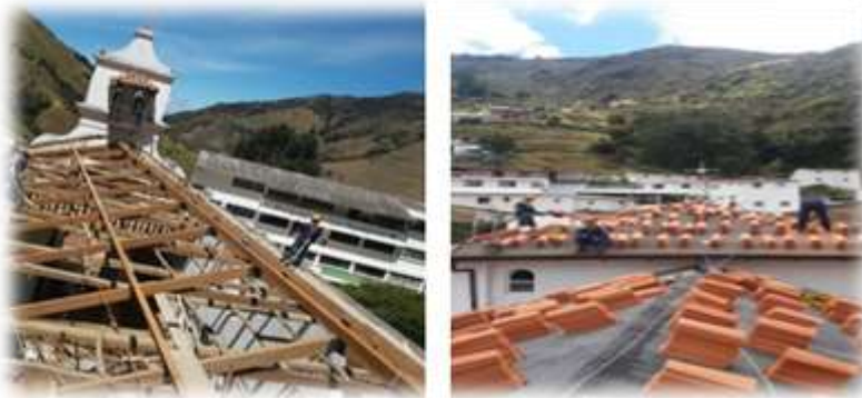
Figura 11. Instalación de estructura de madera y tejas de barro
