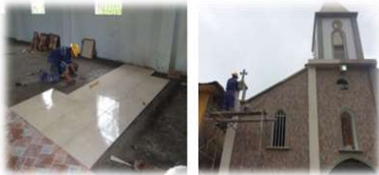
Figura 15. Instalación de acabados en pisos y fachada
