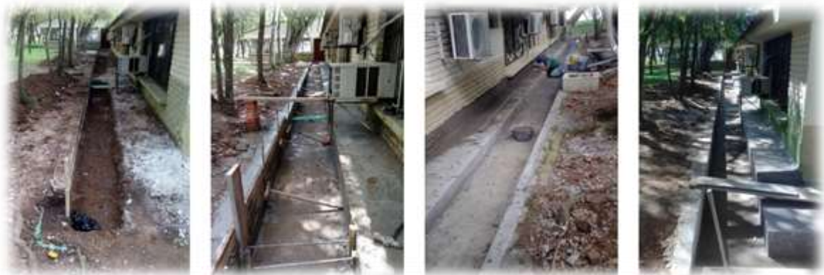
Figura 9. Proceso construcción de cuneta perimetral
