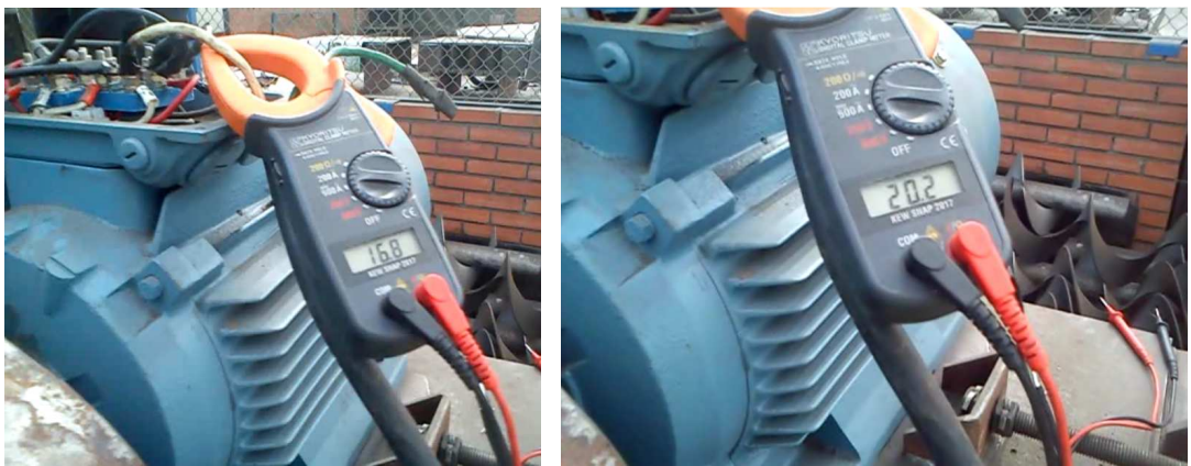
Figura 168. Multímetro midiendo corriente en vacío y en proceso
